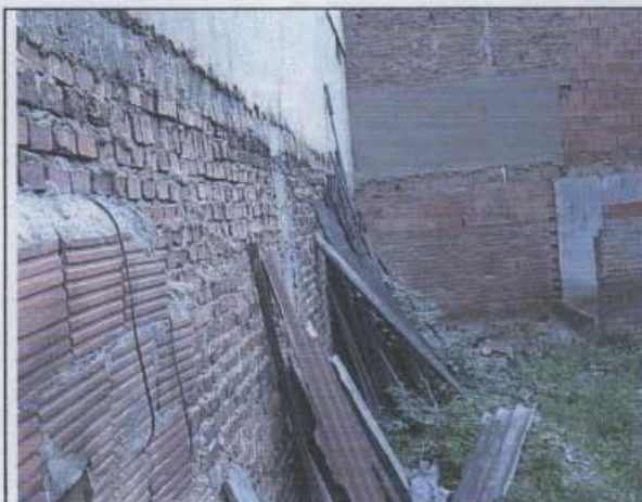
Foto 5. No hay ningún tipo de amarre que genere integralidad de la estructura.
