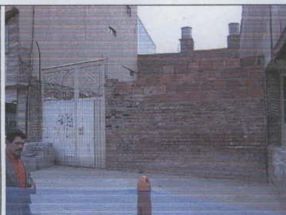
Foto 1. Condiciones de fachada al momento de realizar la visita.
