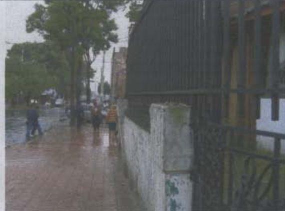
Foto 6. Muro de cerramiento.
