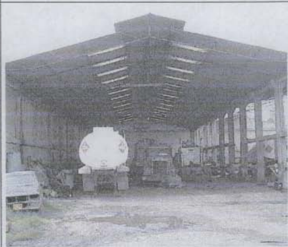
Foto 4. Aspecto interior del inmueble sin daños estructurales observables.
