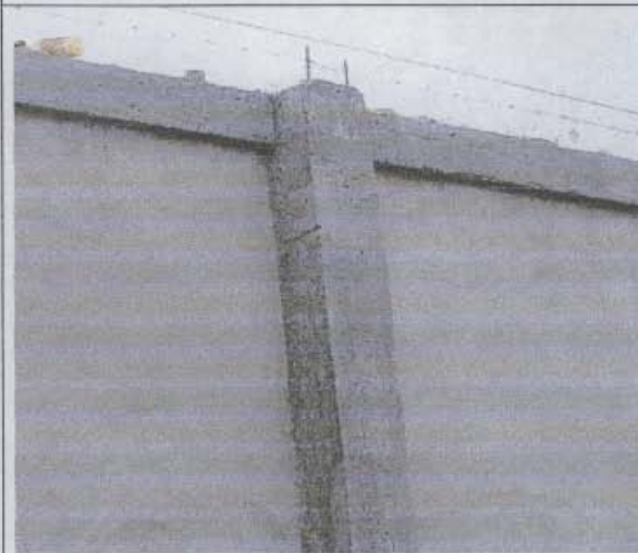
Foto 3. Columnetas de confinamiento del muro.
