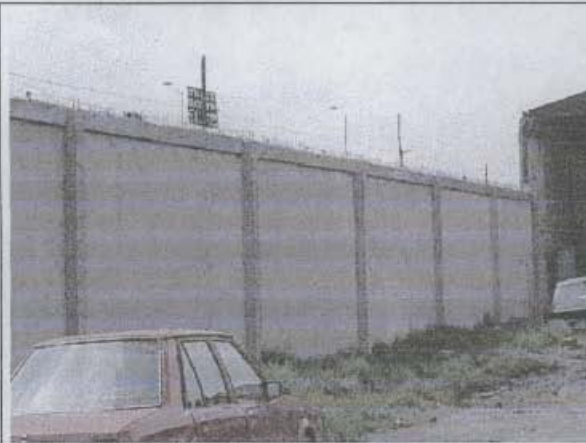
Foto 1. Aspecto general del muro objeto del concepto por el interior del inmueble.
