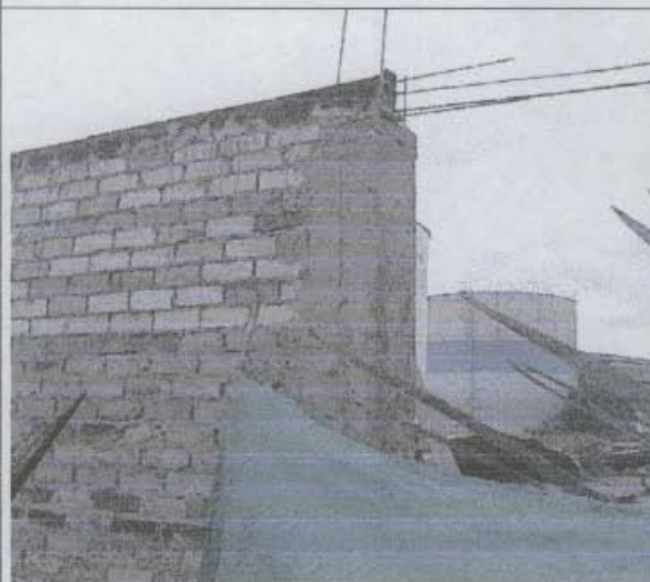
Foto 3. Columnetas de confinamiento del muro.
