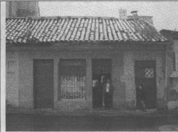
Foto 1. Fachada de la edificación.
