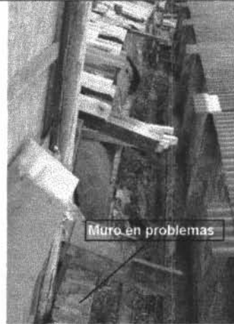
Foto 6. Estructura posterior en demolición
