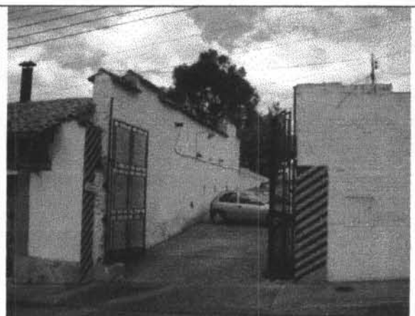
Foto 2. Fachada Calle 33 No. 6 - 20
