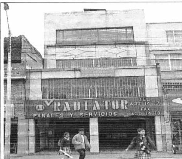
Foto 1. Fachada de la Edificación en las condiciones presentes al momento de la visita.
