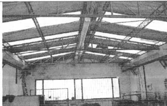
Foto 7. Vista interna de la estructura de cubierta, no se detectó daño alguno.
