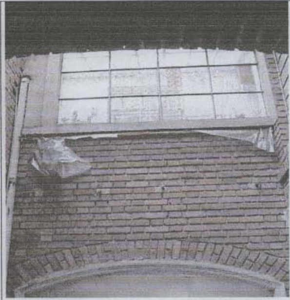
Foto 2. Garaje de acceso al inmueble sin daño estructural que evidencie mal comportamiento.
