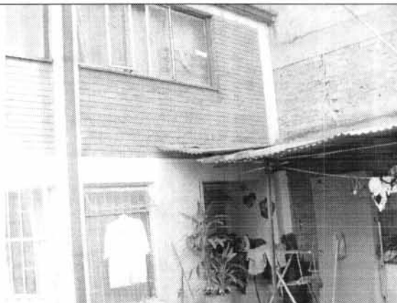
Foto 10. Muros del costado posterior sin daño en elementos estructurales y no estructurales.
