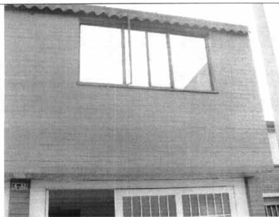
Foto 5. Muros de fachada del segundo piso sin daño externo.
