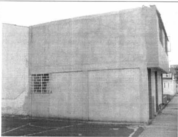
Foto 3. Aspecto general de la fachada del costado sur, no presenta afectaciones.
