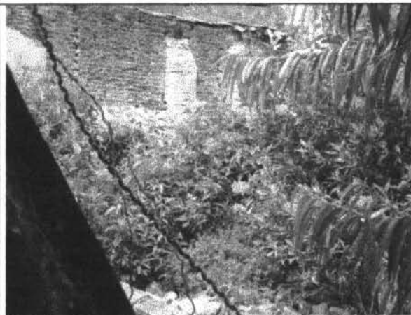
Foto 3. Interior del lote
