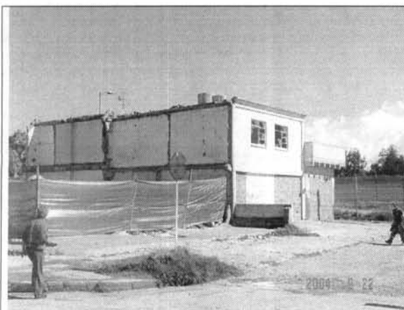
Foto 5. Aspecto del costado norte y occidental.
