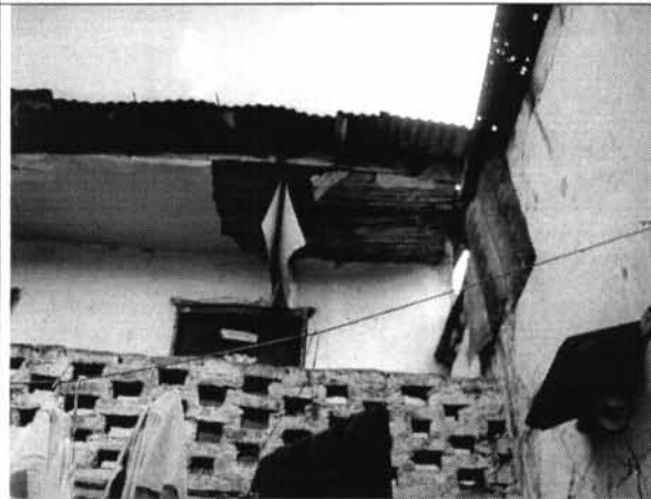
Foto 7. Cubierta con elementos sueltos
