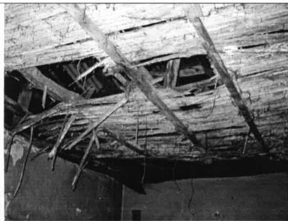
Foto 7. Cubierta con elementos sueltos
