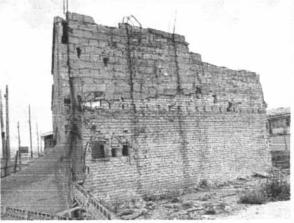
Foto 4. Muros fracturados sin ningún tipo de amarre.
