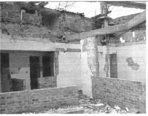
Foto 1. Condiciones de la Edificación - Predio en ruina, con peligro de caída.
