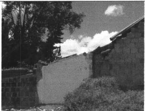
Foto 4. Restos de demolición realizada.
