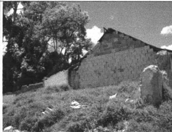
Foto 3. Muros de Culata Norte.
