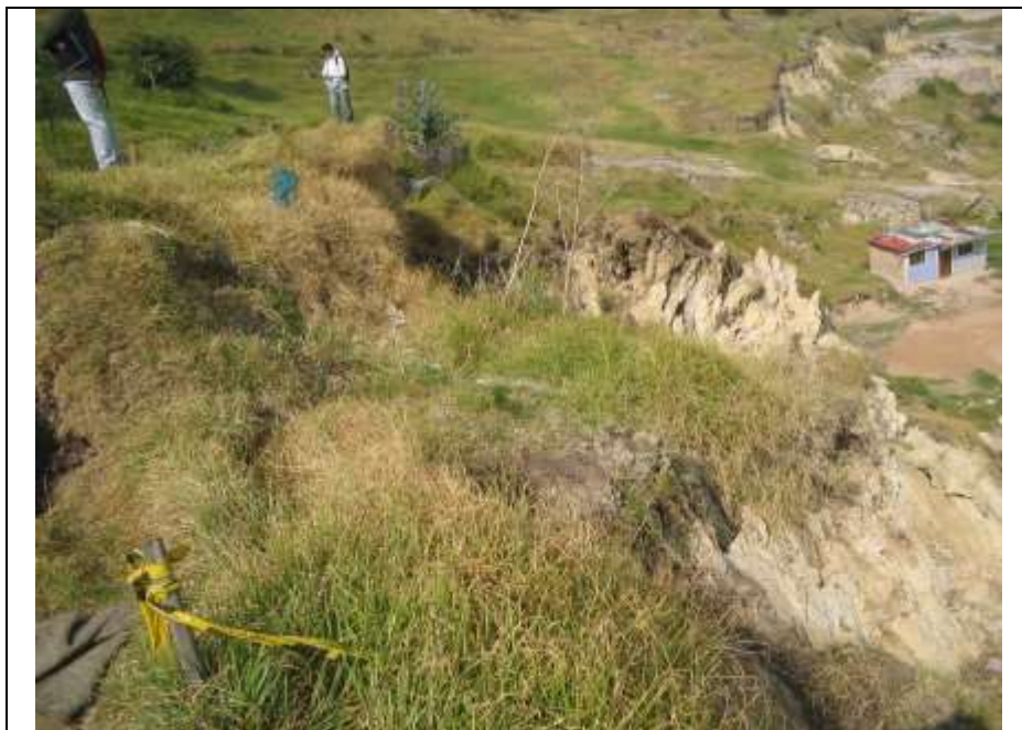
Fotografía 3. Corona del movimiento. A la derecha de la foto se aprecia el volteo de la capa de arenita.
