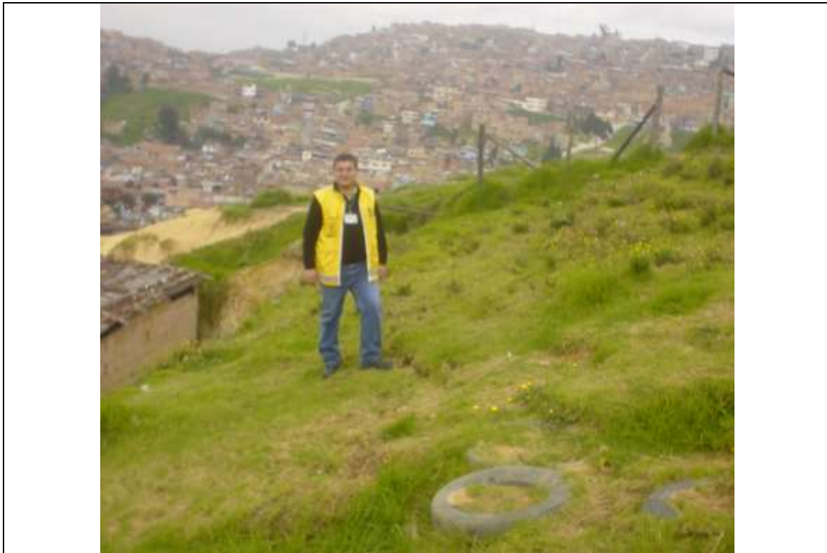
Fotografía 4-2 Zona de agrietamiento unos metros arriba del muro de llantas
