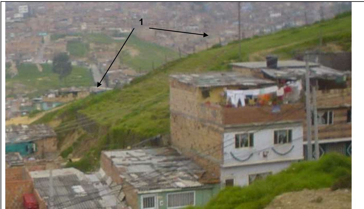
Fotografía 4-1 Zona reconformada (1), ladera arriba del muro de llantas.
