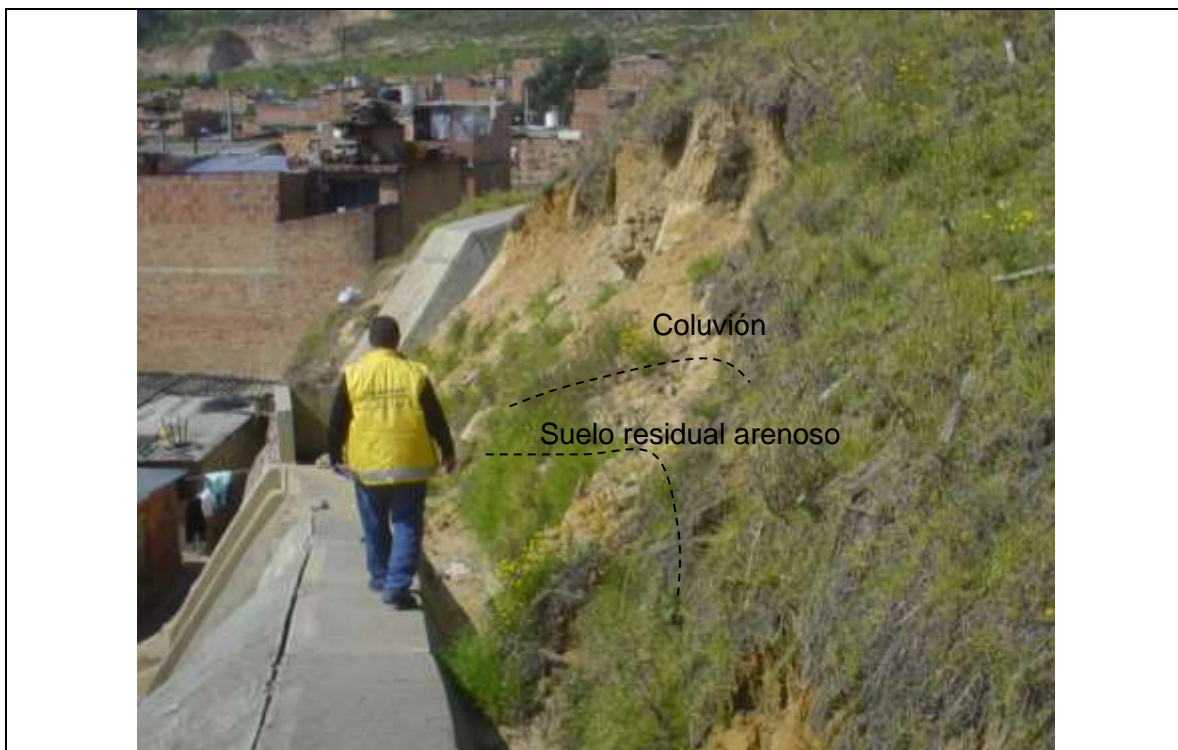
Fotografía 4-5 Aspecto del deslizamiento superficial que se observa en la zona superior a la falla del concreto lanzado. Este deslizamiento involucró un coluvión antiguo y un suelo residual arenoso con fragmentos de roca poco alterada.
