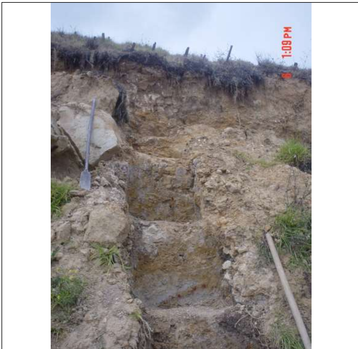
Fotografía 4-4 En la parte superior, coluvión antiguo que suprayace un suelo residual arenoso, con grandes bloques de arenisca y en la parte inferior, suelo residual arcilloso.
