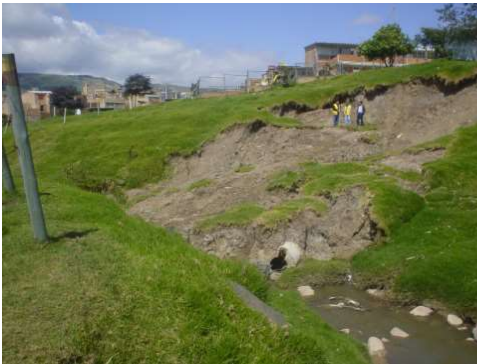
Fotografía 3-1 Deslizamiento en la margen derecha de la quebrada. Obsérvese la disminución de volumen de la masa movilizada debido al transporte continuo de la corriente. .
