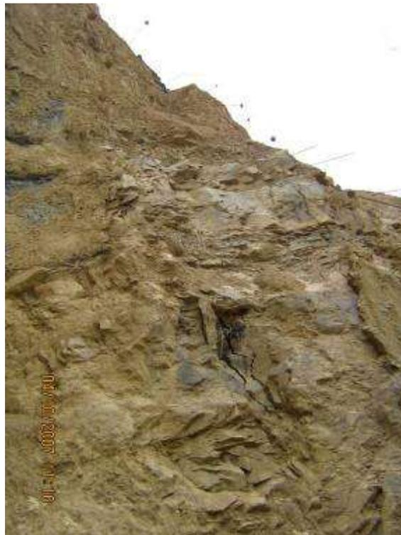
Fotografía 5.5 Continua la facturación intensa dentro del macizo rocoso
