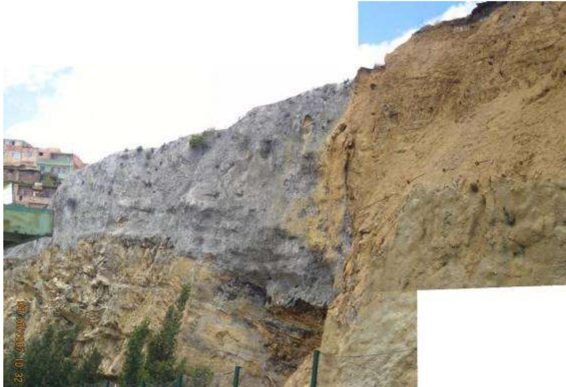
**Fotografía 5.10 Talud inestable relacionado con la generación de la cárcava. Arriba porción del macizo desprendido.**
