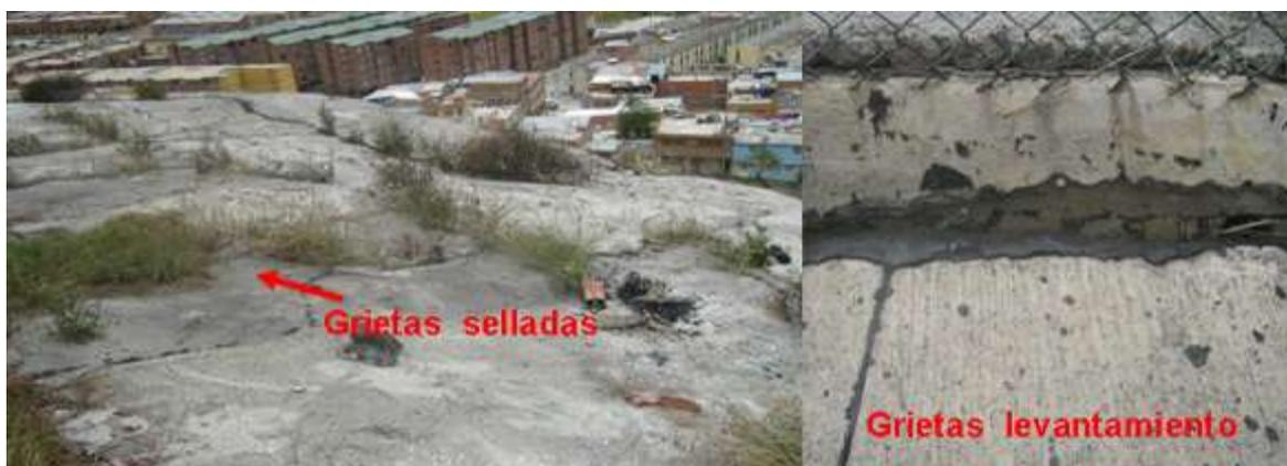
Fotografía 3.3 Grietas en la parte superior del talud y levantamiento respecto a la cuneta
