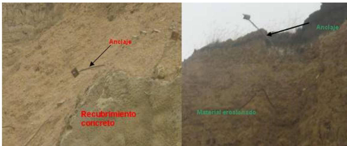
Fotografía 3.2 Detalle de la falla del material por erosión
