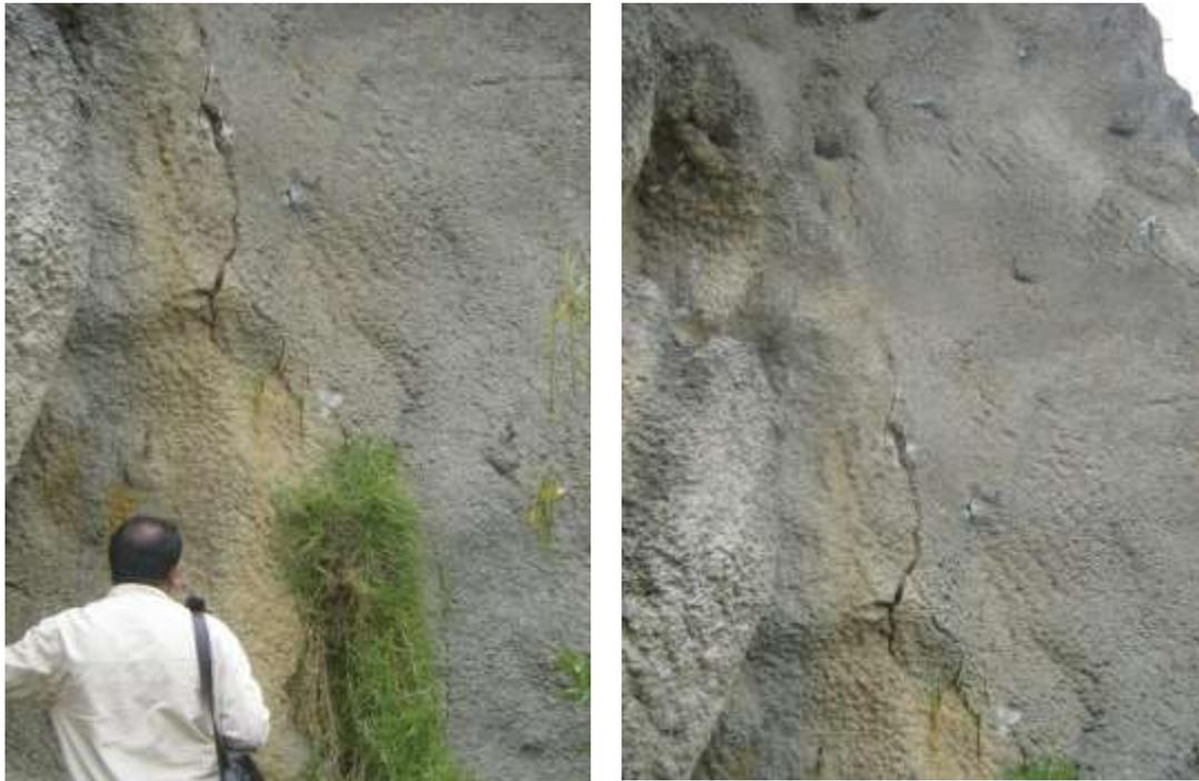
**Fotografía 3.4 Grietas de tracción en le concreto lanzado existente**
