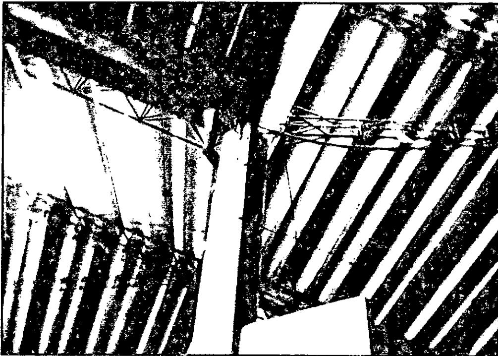
Fotografía N° 12: Columna independiente soportando la cubierta
