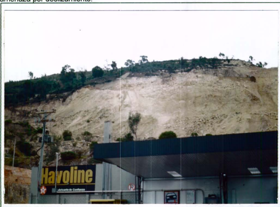
Foto 3. Cantera El Cedro arriba de la carrera 7 con calle 160. Esta cantera inicialmente presentaba un gran deslizamiento en su parte alta la cual tiene taludes de corte verticales, se han venido perfilando durante su explotación, sin embargo todavía existe amenaza por deslizamiento.
