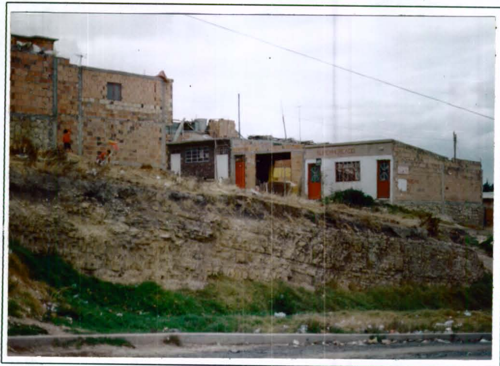
Foto 21. Afloramiento de la Formación Plaeners en la Ciudadela Sucre. Obsérvese que las construcciones se efectuaron sobre una pendiente estructural.
