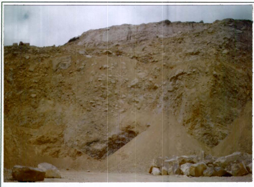
Foto 15. Coluvión de más de 20 m de espesor cubriendo a estratos de la Formación Plaeners, en la cantera de Terreros.
