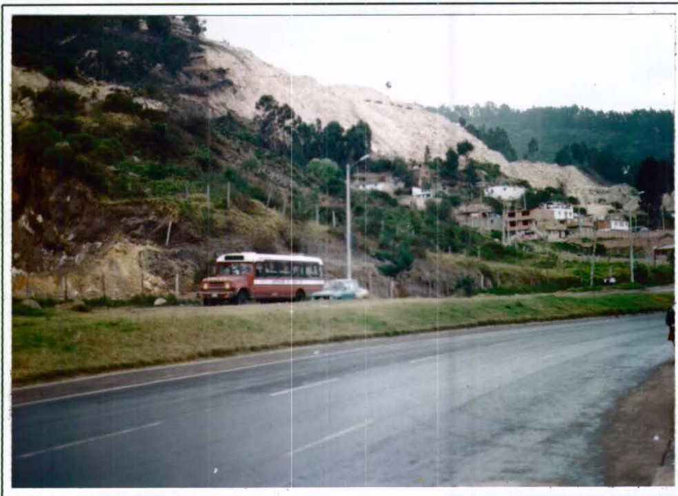
Foto 3. Cantera El Cedro arriba de la carrera 7 con calle 160. Esta cantera inicialmente presentaba un gran deslizamiento en su parte alta la cual tiene taludes de corte verticales, se han venido perfilando durante su explotación, sin embargo todavía existe amenaza por deslizamiento.
