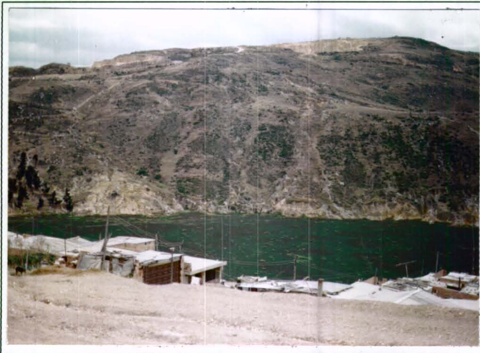
Foto 18. Sector NW de la Represa de Terreros. Nótese el intenso Carcavamiento que afecta a esta zona y el embalse cubierto por vegetación.
