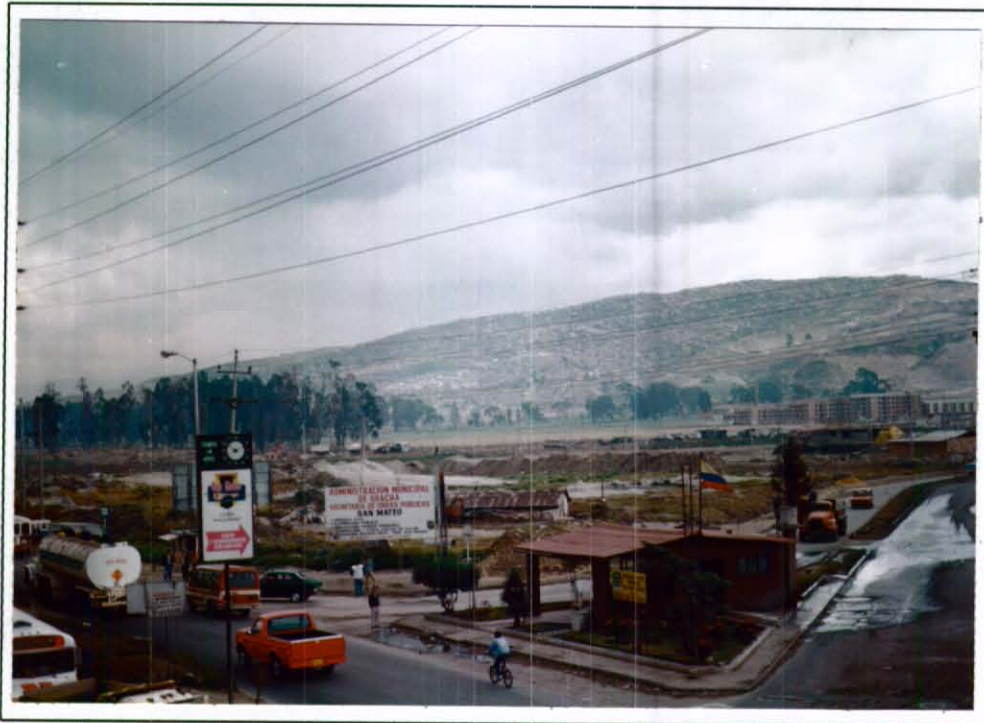
Foto 34. Parte SW del área de estudio. Parte superior Barrio Simón Bolívar, construido en gran parte sobre antiguas canteras. En la parte media de la foto se denota el cono de Terreros, ligeramente inclinado hacia el SW.
