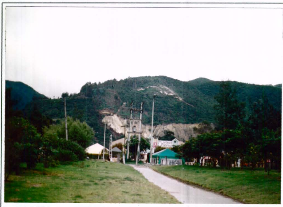
Foto 14. Cantera ubicada arriba de la Cra 7ª frente a Nimaya. Obsérvese el corte vertical de excavación y el impacto físico en este sector de los Cerros Orientales.
