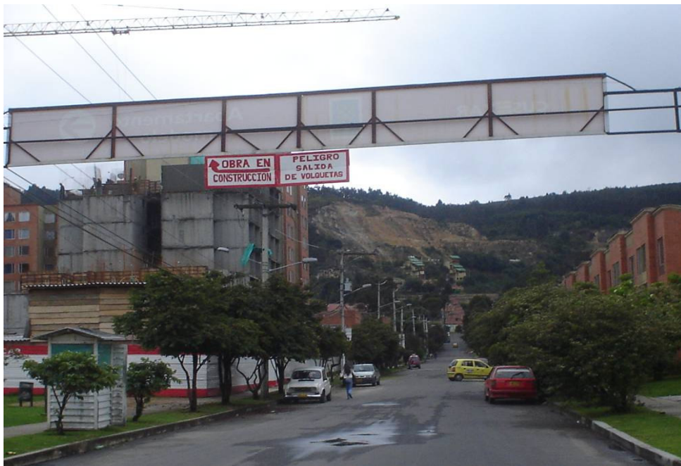
Fotografía No. 60 Calle 175. Vista hacia los cerros Orientales aguas arriba de la Carrera 7ª, hacia una cantera, muy importante productora de sedimentos.
