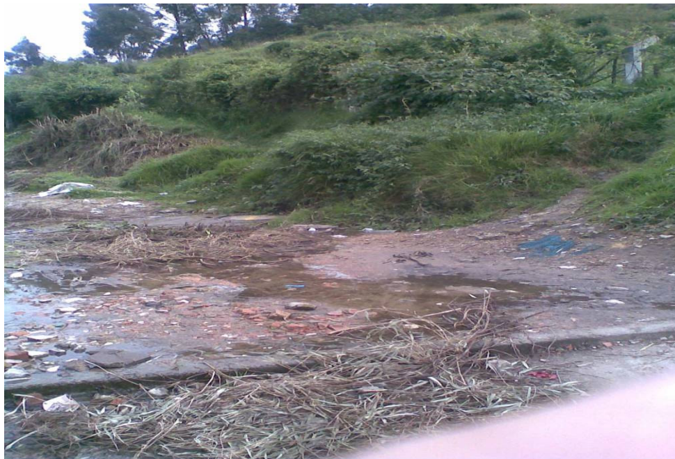
Fotografía No. 62 Calle 175 Carrera 6ª, Colegio Claustro Moderno. Las aguas bajan sin control hacia la Carrera 6ª desde la parte Oriental, con sedimentos.
