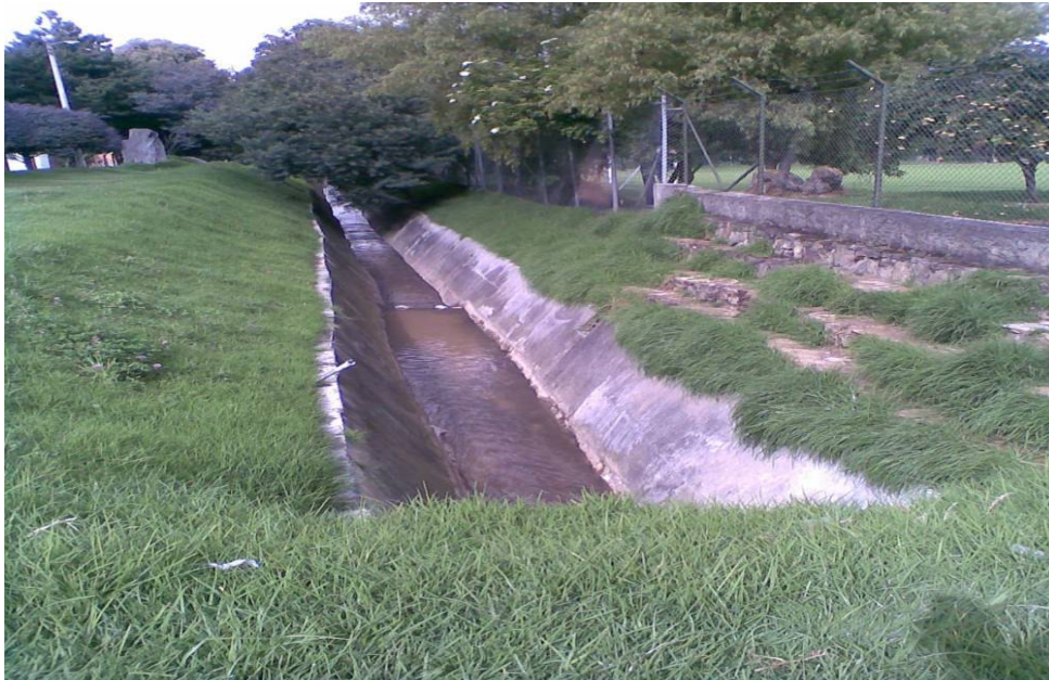
Fotografía No. 57 Calle 175 Carrera 7ª A. Vista hacia aguas abajo del canal desarenador de escorrentía que baja de ese sector.
