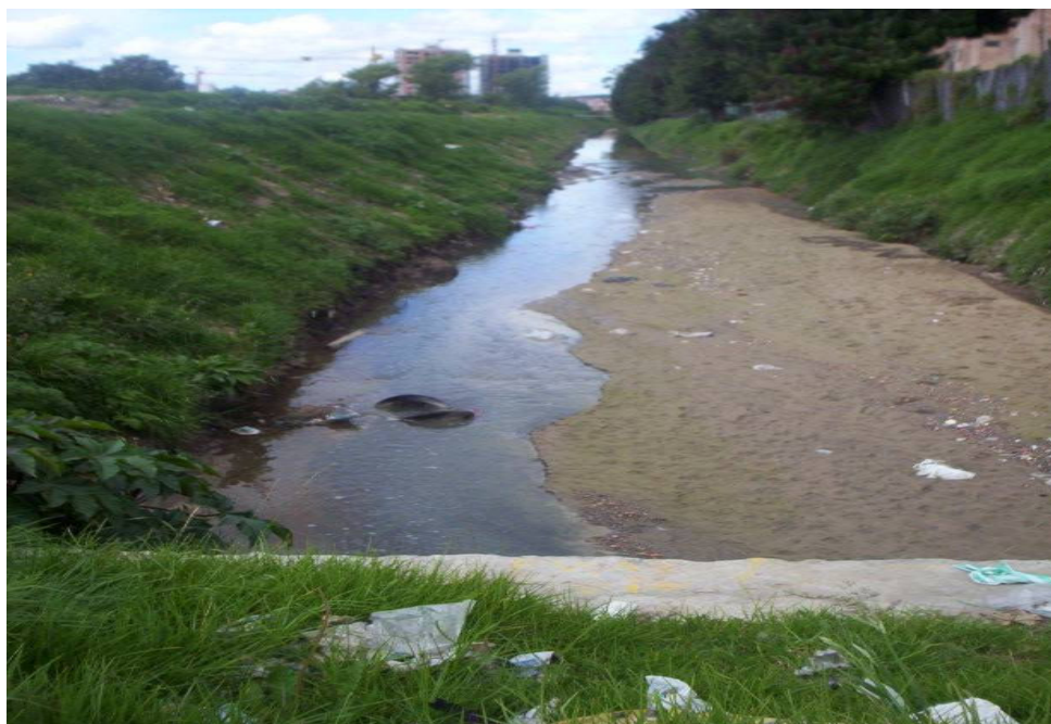
Fotografía No. 53 Calle 180 con carrera 10. Canal Guanica, en este canal depositan basuras y sobrantes del cultivo de papá (foto anterior) que se encuentra al costado sur.
