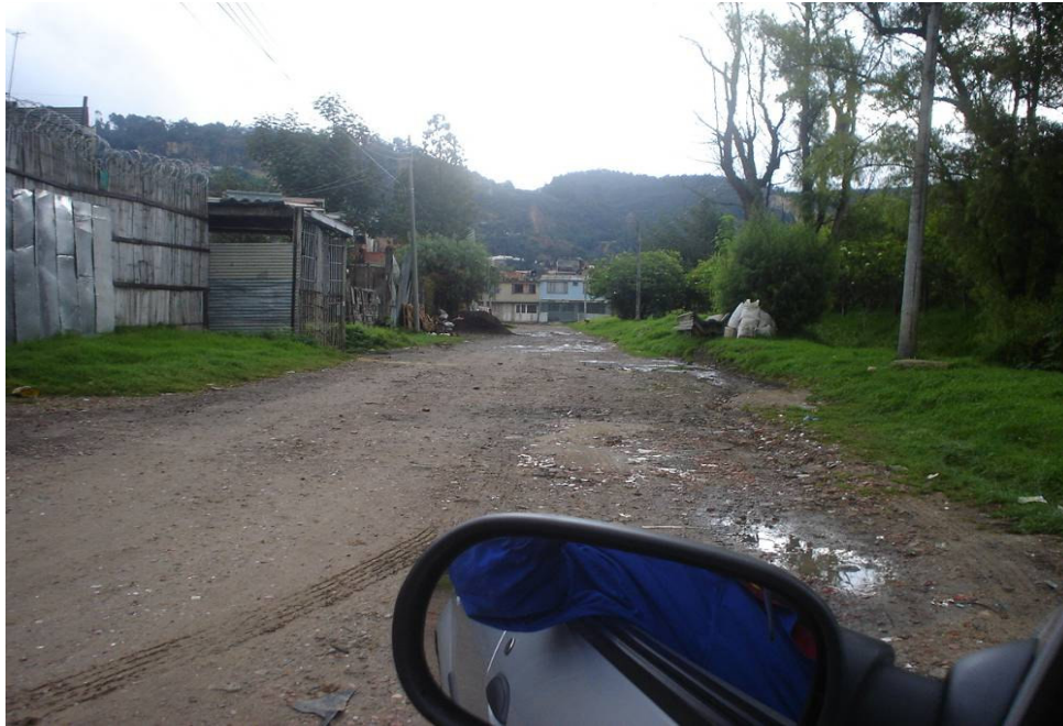
Fotografía No. 51 Calle 180 entre Carreras 8ª y 8ª D. La vía se encuentra sin pavimentar, produciendo sedimentos hacia aguas
