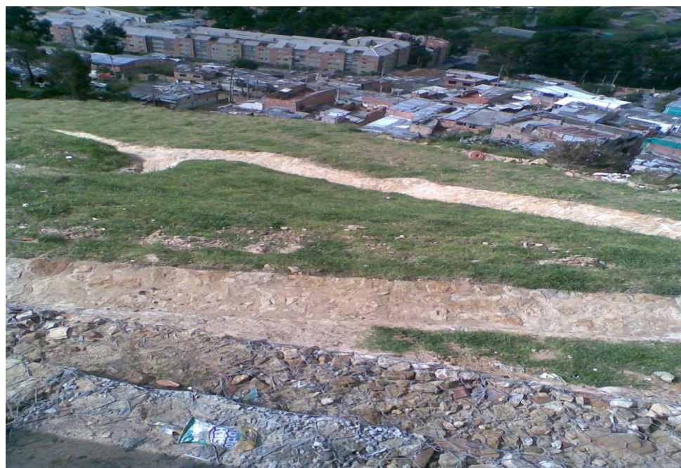
Fotografía No. 6 Calle 182 Carrera 1ª. Vista desde los cerros Orientales hacia el occidente. El talud ha sido tratado en esta zona con canales interceptores de escorrentía.
