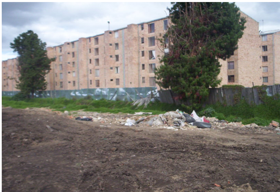
Fotografía No. 54 Calle 180 con carrera 10. Costado norte del canal Guanica, depositan basuras y escombros de las construcciones aledañas al canal.
