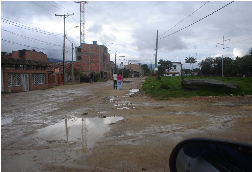
Fotografía No. 41 Carrera 9ª, Calles 183 a 182. Apozamientos de agua por falta de pavimentación, produciéndose transporte de sedimentos. Sobre esta zona del ferrocarril se producen inundaciones.
