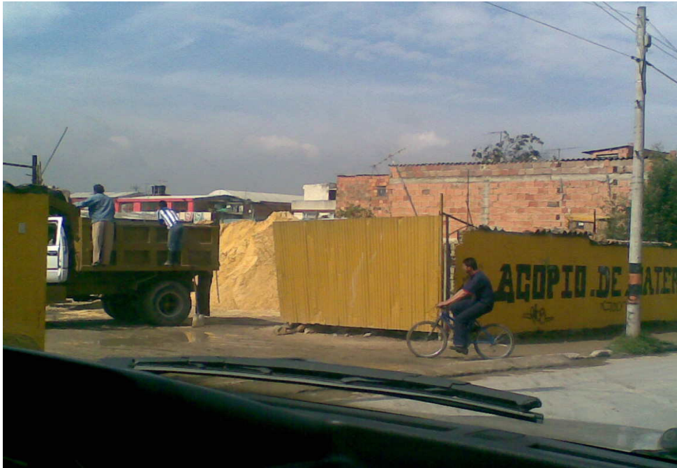
Fotografía No. 37 Calle 183 No. 7A - 41 . Depósitos de materiales para construcción. Debido a lluvias o a mal manejo de estos, los sedimentos salen a las vías
