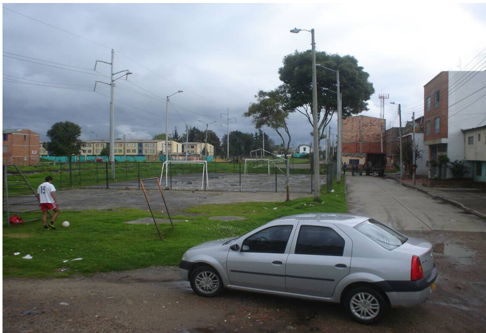
Fotografía No. 50 Calle 180 Carrera 9ª. El sistema de alcantarillado de esta zona está conectado al canal de drenaje de la fotografía anterior. Este canal se presenta con basura, que lo hace insuficiente para el agua que recibe.
