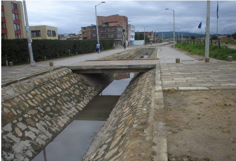
Fotografía No. 31 Canal al occidente de la Calle 189 con Carrera 9ª. Nótese la gran diferencia urbanística entre el sector en este costado de la vía del ferrocarril y el costado oriental.
