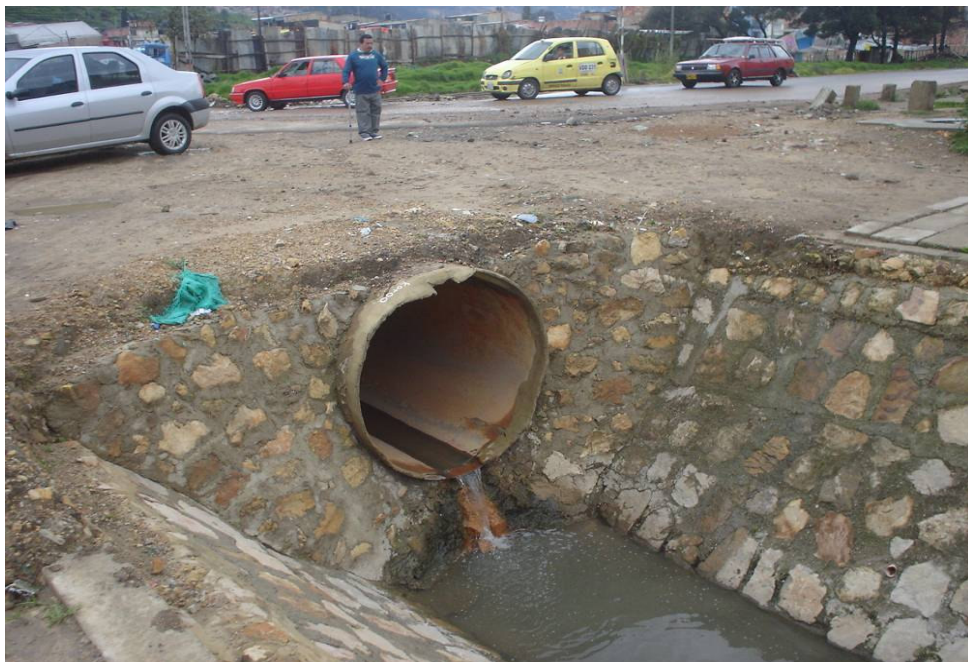
Fotografía No. 32 Llegada de tubería de aguas lluvias al canal al occidente de la Calle 189 con Carrera 9ª, presentado en la fotografía anterior. Aún en esta zona la vía parcialmente se encuentra sin pavimentar.
