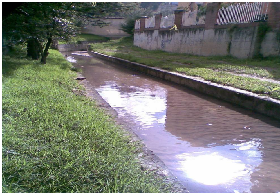
Fotografía No. 55 Calle 175 Carrera 7ª A. Canal desarenador de escorrentía que baja de ese sector.
