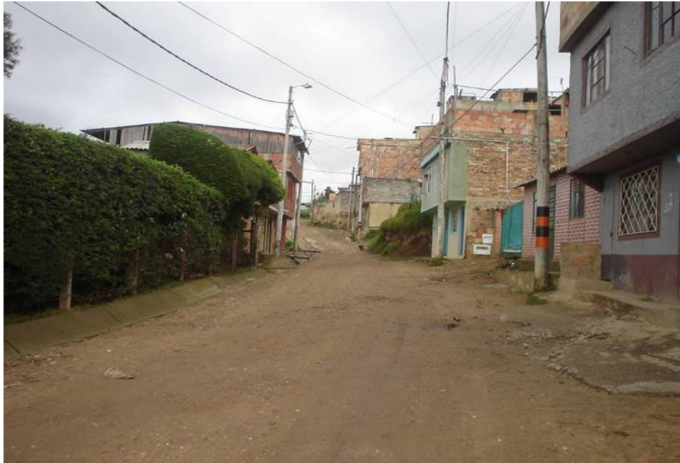
Fotografía No. 7 Carrera 1ª entre Calles 180 a 183. Vías desprovistas de pavimento, productoras de sedimentos.
