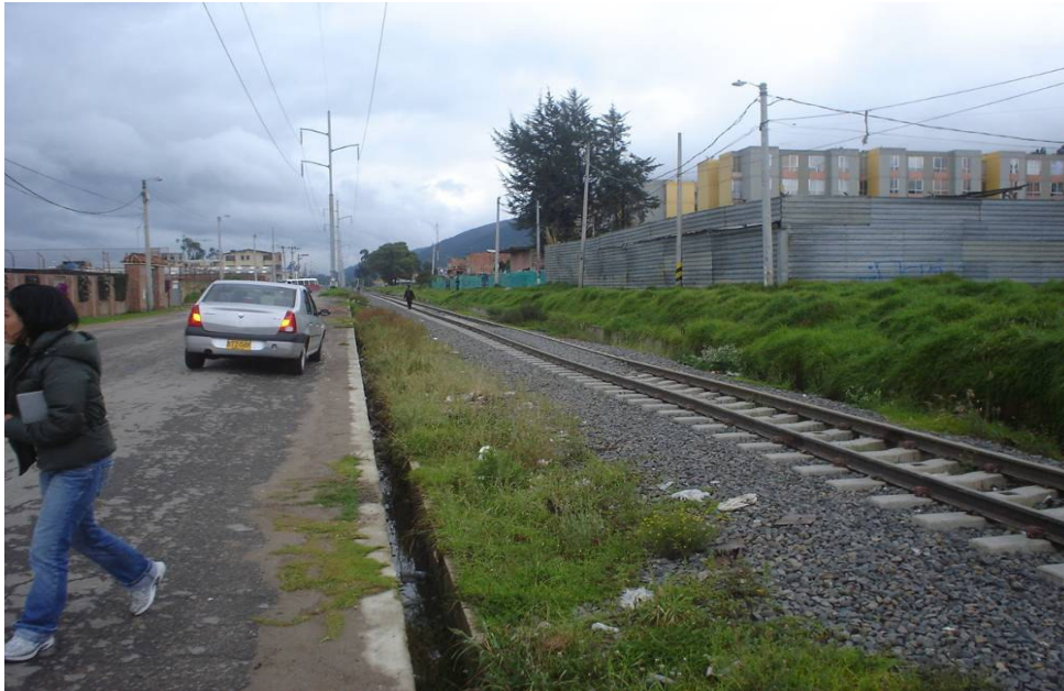
Fotografía No. 35 Carrera 9ª Calle 185 B hacia el norte. La vía del ferrocarril opera como un dique de la escorrentía que no es captada por las vías que afluyen a ésta.
