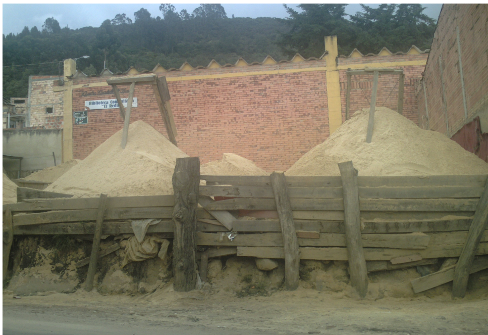
Fotografía No. 19 Carrera 4ª con calle 190B. Centro de Acopio de arena.
