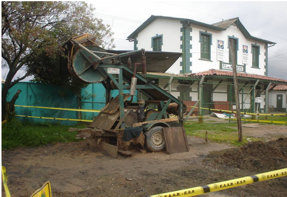
Fotografía No. 43 Calle 182 Carrera 9ª. Máquina con la cual se extraen los sedimentos por parte de la EAAB.
