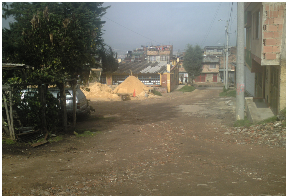
Fotografía No. 18 Calle 190B entre carreras 4ª y 3ª. Centros de Acopio de arena.
