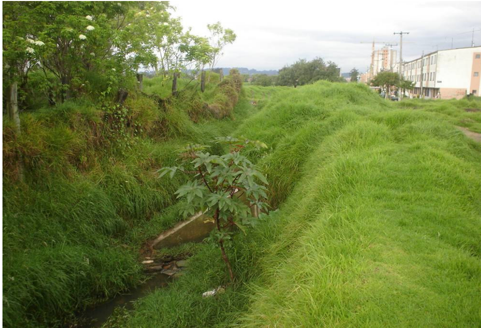
Fotografía No. 49 Calle 180 Carrera 9ª. Canal proveniente de la Universidad de La Salle, más al Oriente, el cual está canalizado cuatro (4) cuadras más aguas abajo.
