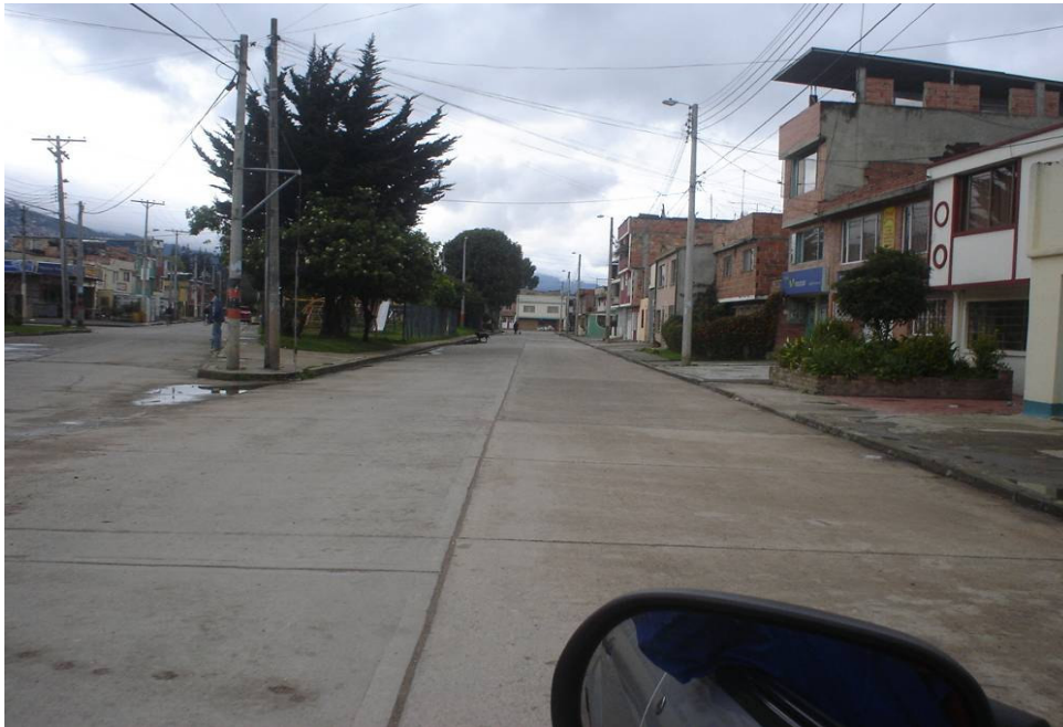
Fotografía No. 47 Carrera 8ª D entre Calles 182 y 181. Como en algunas áreas pavimentadas de la parte plana, no existen sumideros para recoger la escorrentía, produciéndose acumulaciones de agua en algunos sectores.
