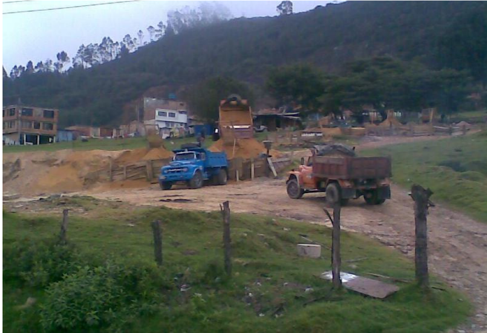
Fotografía No. 11 Cra.2ª con calle 188. Centro de acopio de arena.
