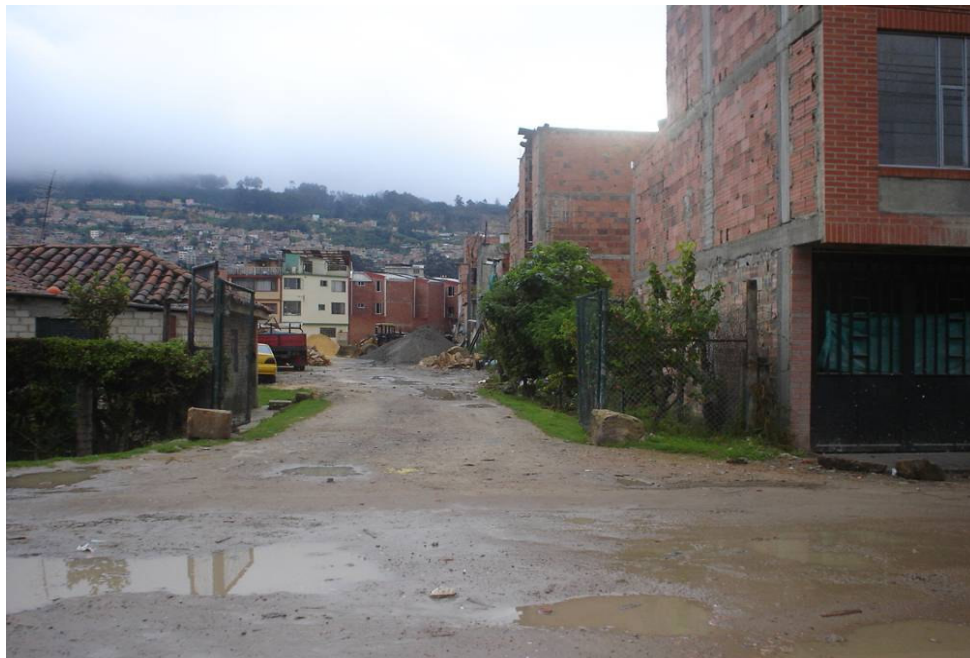
Fotografía No. 40 Carrera 9ª Calles 183 a 182. Depósitos de materiales para construcción. Debido a lluvias o a mal manejo de éstos. los sedimentos salen a las vías.
