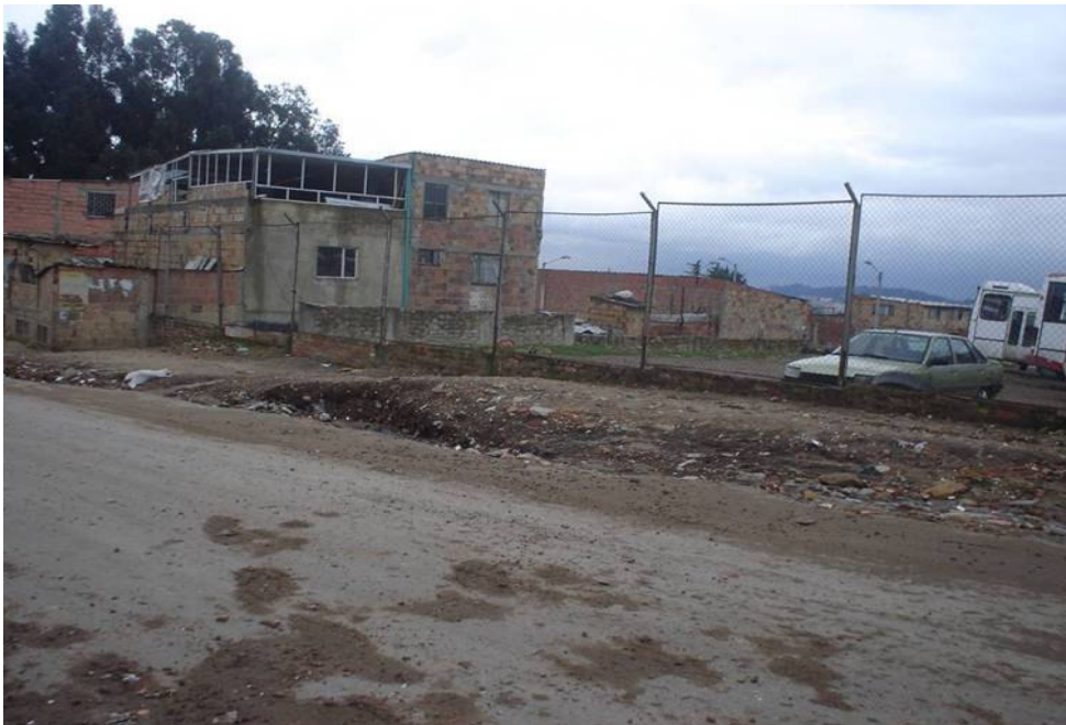
Fotografía No. 14 Carrera. 5ª entre calles 185 a 189. Vía totalmente destapada, productora de escorrentía y sedimentos.
