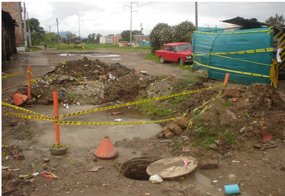
Fotografía No. 46 Calle 182 Carrera 9ª. Segundo pozo más al sur del pozo anterior, de donde se extraen sedimentos del alcantarillado pluvial por parte de la EAAB.
