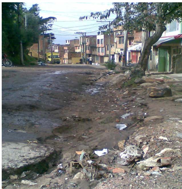
Fotografía No. 17 Carrera 4ª Con calle 191 (sentido norte - sur). Vía desprovista de sedimentos, obsérvese que no posee canales para el control de escorrentía.
