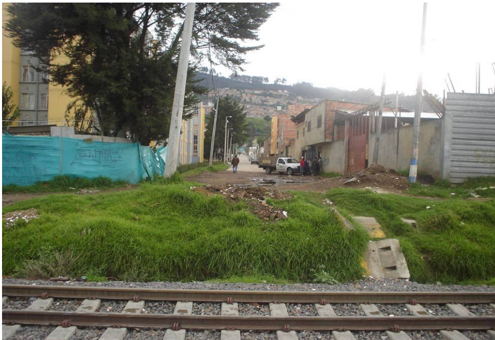
Fotografía No. 34 Calle 186 Carrera 9ª. El agua no captada por las vías (algunos tramos se encuentran sin pavimentar) afluyen a la vía del ferrocarril desbordándose o produciendo inundaciones.
