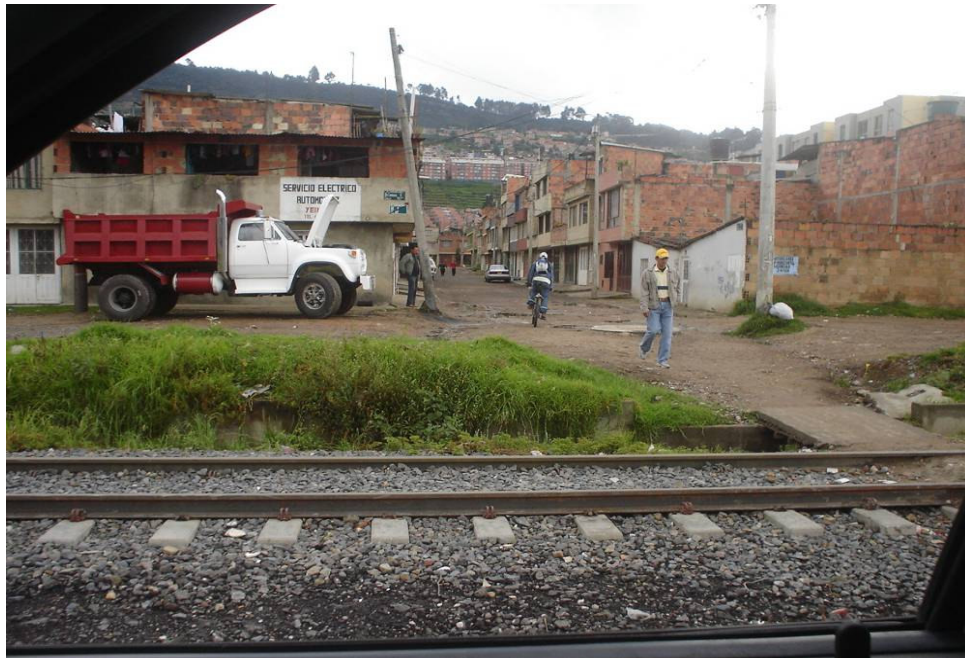
Fotografía No. 33 Calle 187A Carrera 9ª. El agua no captada por la vía afluye a la vía del ferrocarril con sedimentos, desbordándose o produciendo concentraciones indeseables de agua.
