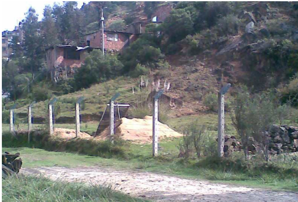
Fotografía No. 2 Carrera 4ª con calle 180. Acopio de Arena
