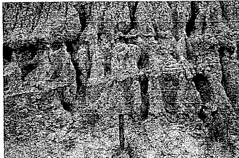
Fotografía 1: Parte inferior del talud superior del costado sur; surcos de erosión que se han profundizado progresivamente en el tiempo.
