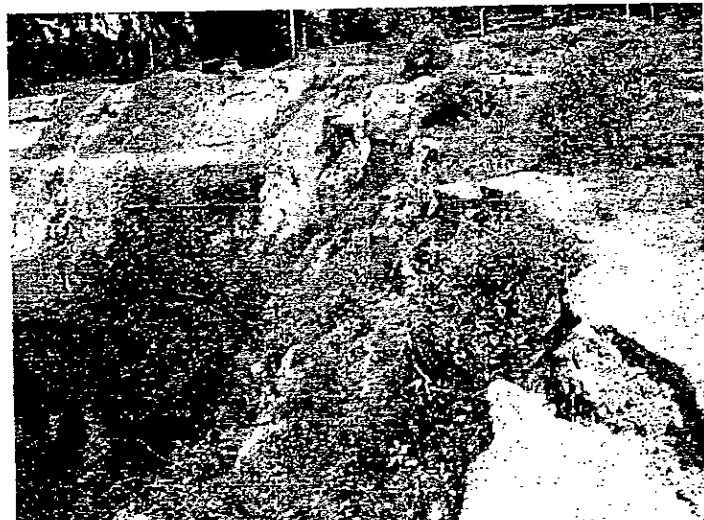
Fotografías 4a, 4b: Se observa la parte de la cara norte del Dique transversal donde se presentan desprendimientos de bloques de suelo, estos desprendimientos aunque pequeños se vienen presentando con mayor frecuencia en las últimas campañas.
