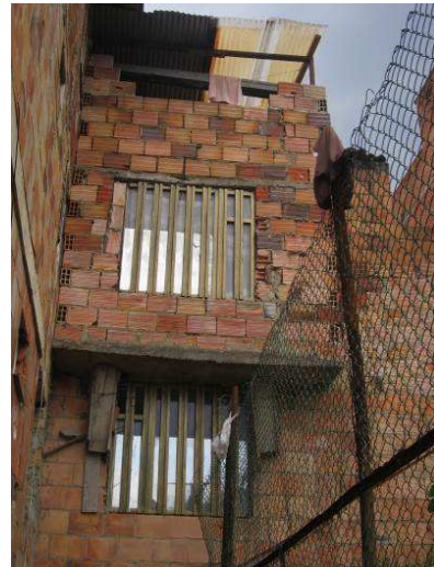
FOTOS 7.8 Y 7.9 PÉRDIDA DE CCONTINUIDAD DEL SISTEMA ESTRUCTURAL POR LA INCORPORACIÓN DE ELEMENTOS CERÁMICOS DE PERFORACIÓN HORIZONTAL EN LAS AMPLIACIONES HECHAS POR LOS PROPIETARIOS DE LAS EDIFICACIONES
