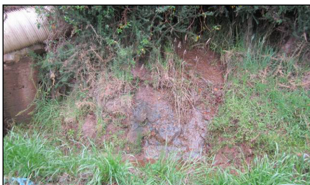
FOTO 3.2 AFLORAMIENTO ALEDAÑO EN EL QUE SE DESTACA EL GRADO DE FRACTURAMIENTO DE LA ROCA
