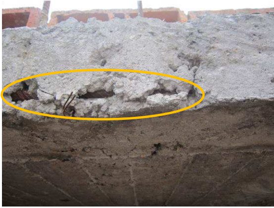
FOTO 7.7 REFUERZO EXPUESTO Y HORMIGONEO EN ELEMENTOS FUNDIDOS POR LOS PROPIETARIOS
