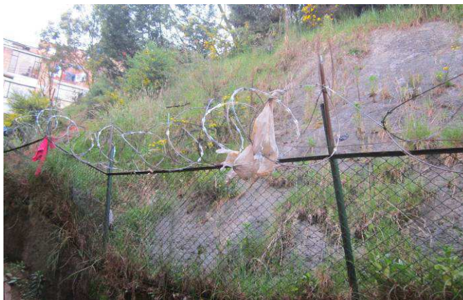
FOTO 3.5 TALUDES EXTRACTIVOS EN ARCILLOLITAS
