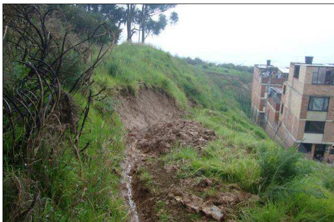
FOTO 1.3 PANORÁMICA DEL DESLIZAMIENTO, TALUD SUR OCCIDENTAL. FUENTE: FOPAE, 2010
