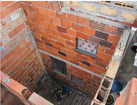
FOTOS 7.8 Y 7.9 PÉRDIDA DE CCONTINUIDAD DEL SISTEMA ESTRUCTURAL POR LA INCORPORACIÓN DE ELEMENTOS CERÁMICOS DE PERFORACIÓN HORIZONTAL EN LAS AMPLIACIONES HECHAS POR LOS PROPIETARIOS DE LAS EDIFICACIONES
