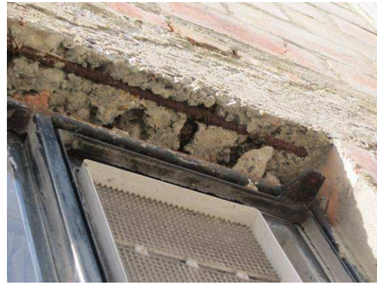
FOTO 7.7 REFUERZO EXPUESTO Y HORMIGONEO EN ELEMENTOS FUNDIDOS POR LOS PROPIETARIOS
