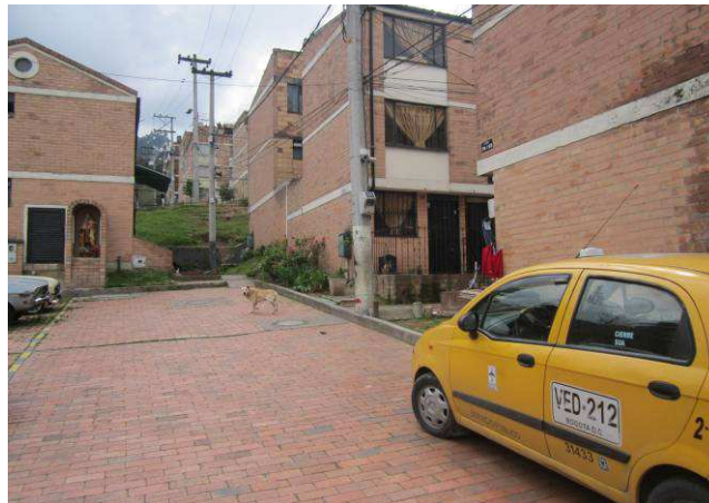
FOTO 3.6 TALUD DE RELLENOS PERIMETRALES A LA EXPLANACIÓN
