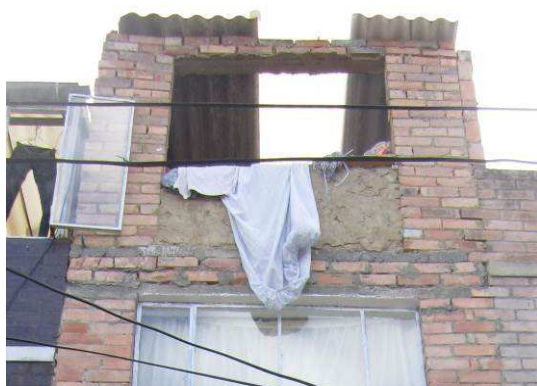
FOTOS 7.5 Y 7.6 DEFICIENCIAS COMUNES EN LA AUTOCONSTRUCCIÓN EN LA SEGUNDA ETAPA
