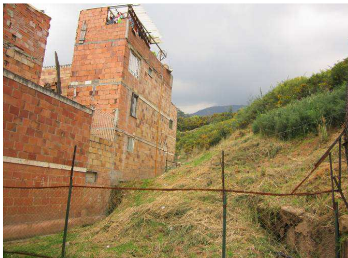
FOTO 3.8 PATA Y CUERPO DEL DESLIZAMIENTO DT001-I
