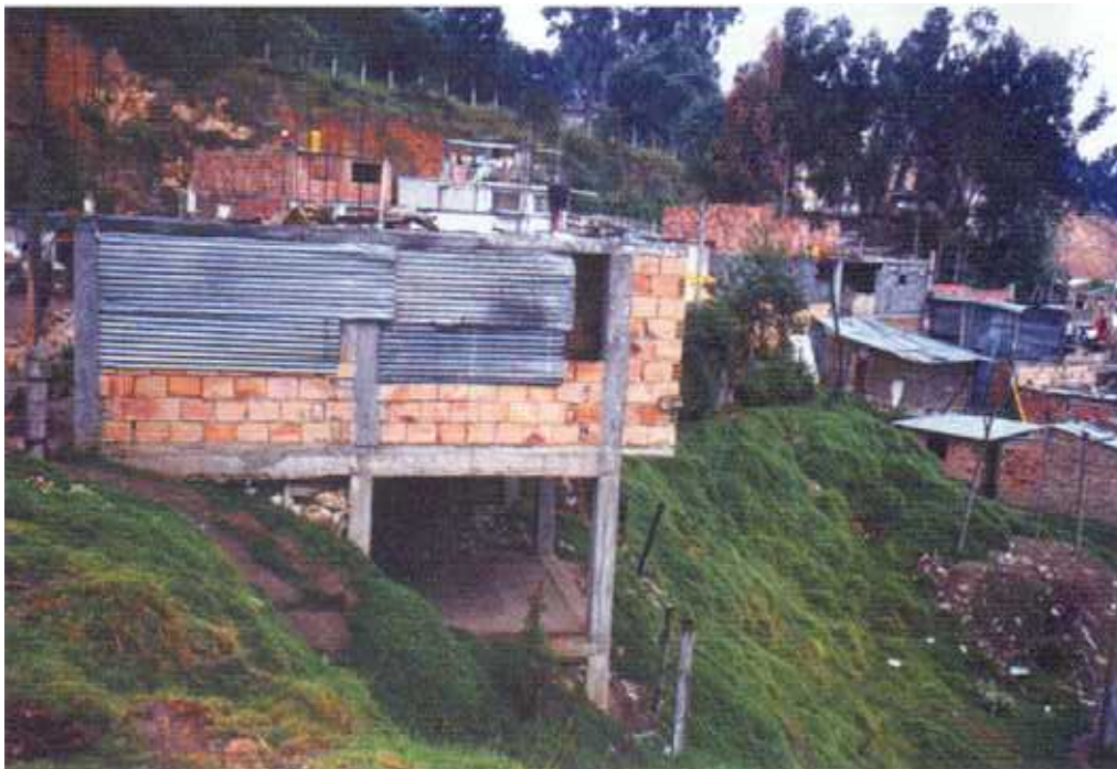
Barrio El Mirador. Localidad Usaquén. Construcción vulnerable por el tipo de apoyo (estructuras palafíticas).
