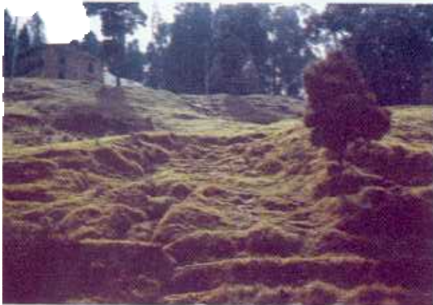
Sitio: Av. Circunvalar, frente a la Universidad América. Localidad Santafé. Superficies irregulares, hundimientos.
