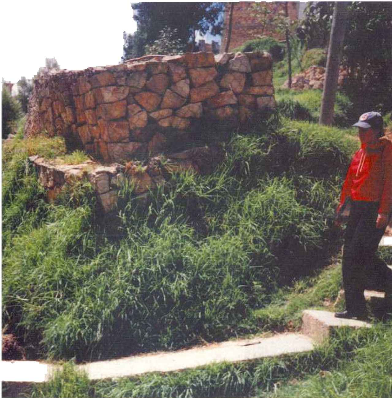
Barrio Nueva Colombia. ..... Localidad Ciudad Bolívar. .... Gaviones volcados y destruidos ..... por movimientos ..... de tierra. ....
