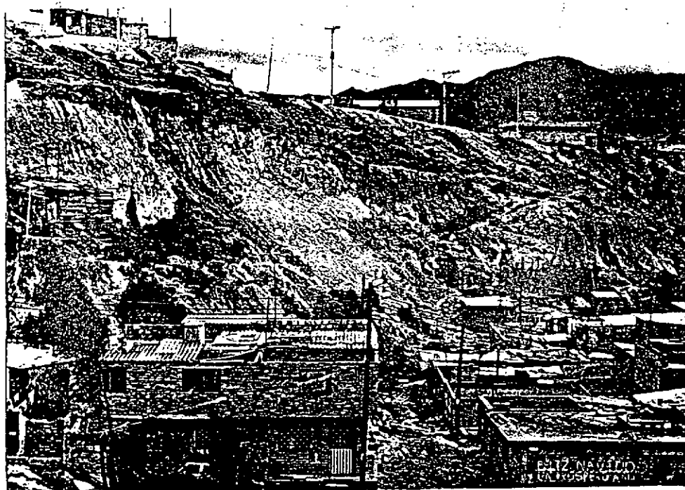
Foto No. 5. Sector La Casona. Sitio No.1. Vista sobre Inclinación de taludes. (Véanse la acumulación de material sobre pared de la casa # 20D-20).
