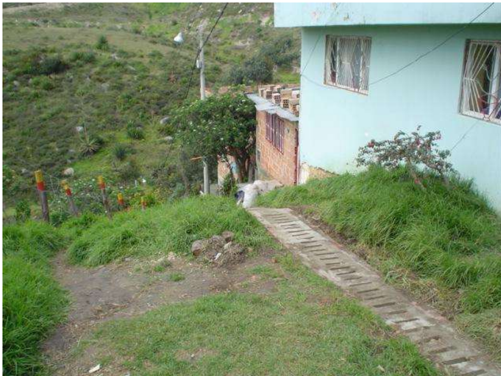
Fotografía 10. Viviendas vecinas al escarpe; se muestra el sistema de alcantarillado de aguas lluvias.
