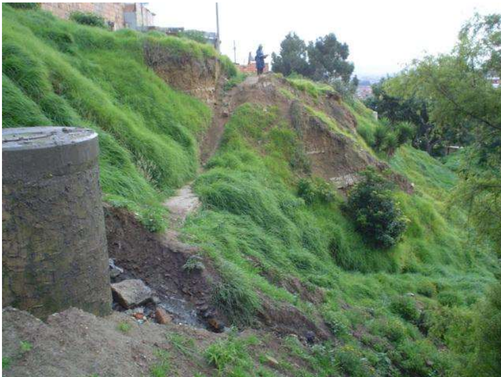
Fotografía 27. Sector adyacente a la zona inestable, se aprecia un afloramiento de la roca y las huellas de las excavaciones para la instalación del alcantarillado.
