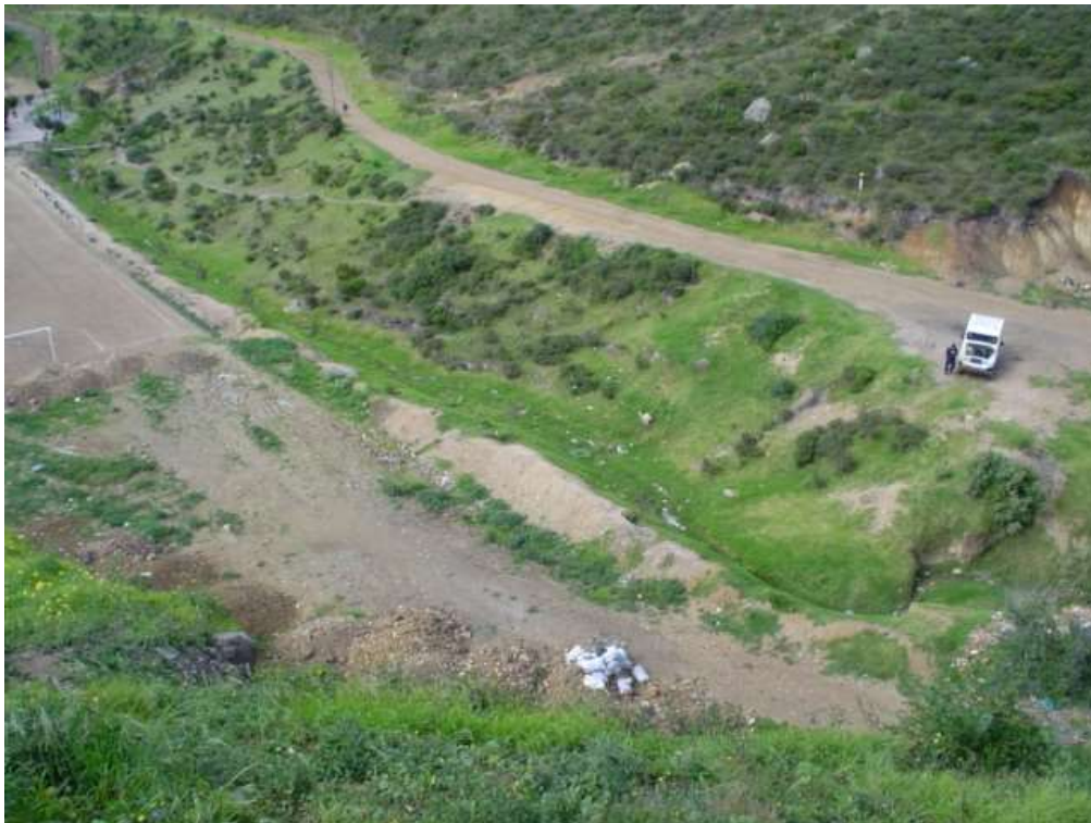
Fotografía 14. Patio de la antigua explotación, se aprecia la vía de acceso y el cauce de la quebrada.
