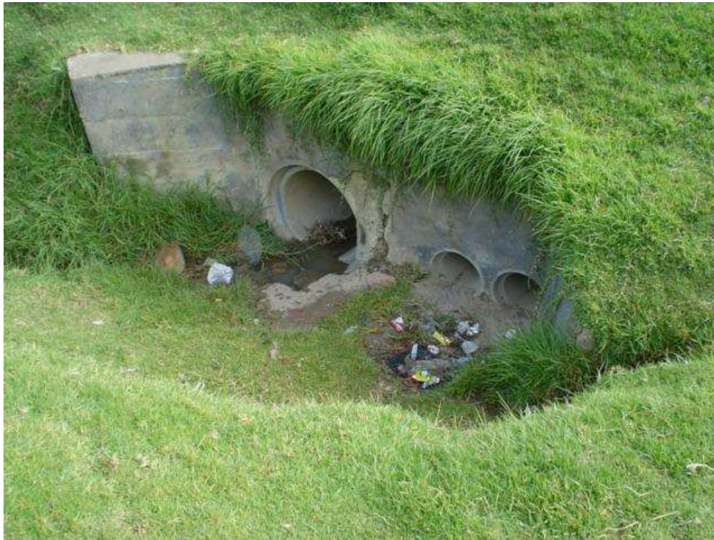
Fotografía 5. Entrada a la alcantarilla.
