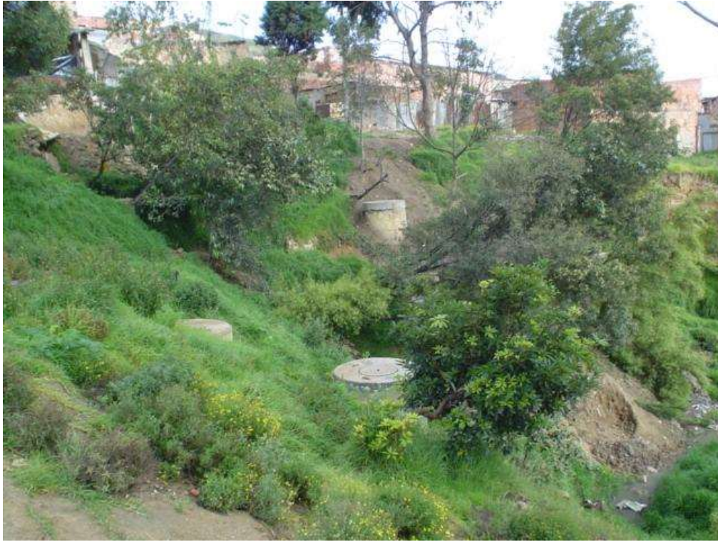
Fotografía 30. Vista lateral de la zona inestable de la foto anterior.
