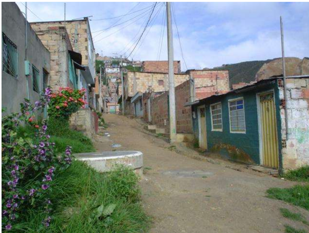
Fotografía 37. Calle 69 L Sur; las viviendas se encuentran en buen estado.
