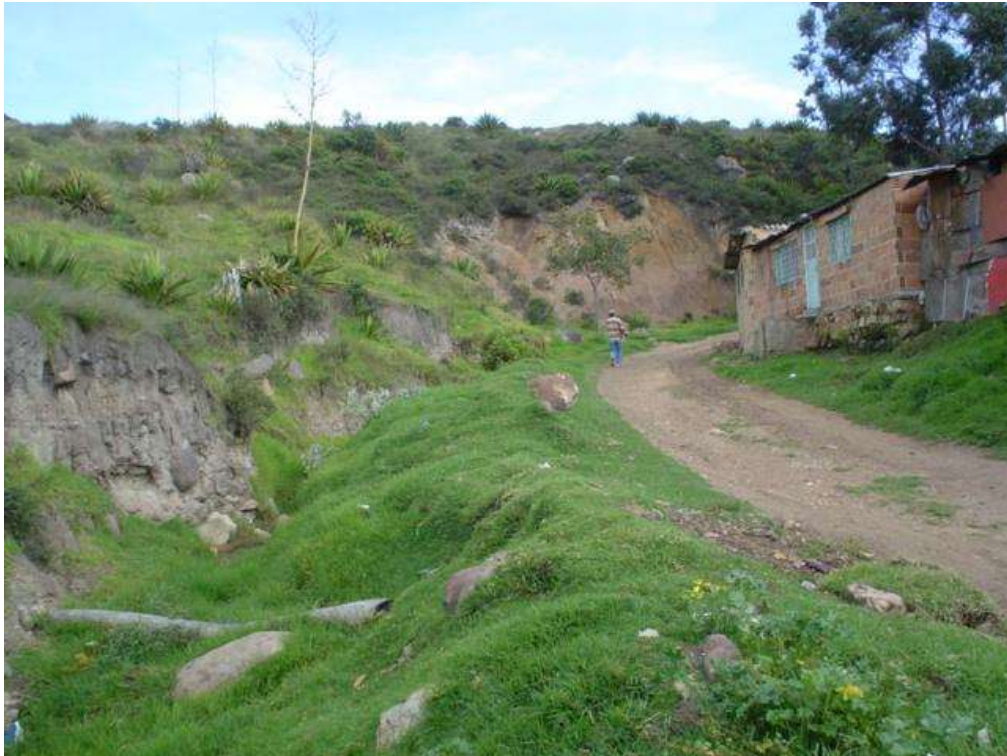
Fotografía 2. Cauce de la quebrada Trompetica, arriba de los puntos de desborde.
