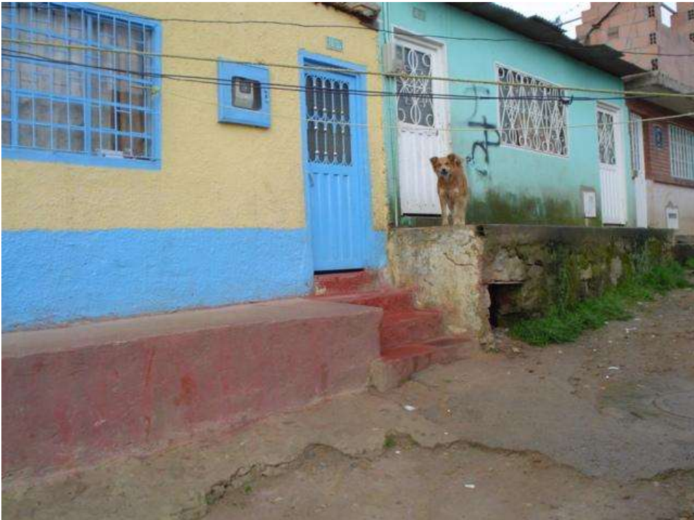
Fotografía 35. Vivienda vecina a la de la foto anterior; se encuentra en buen estado.
