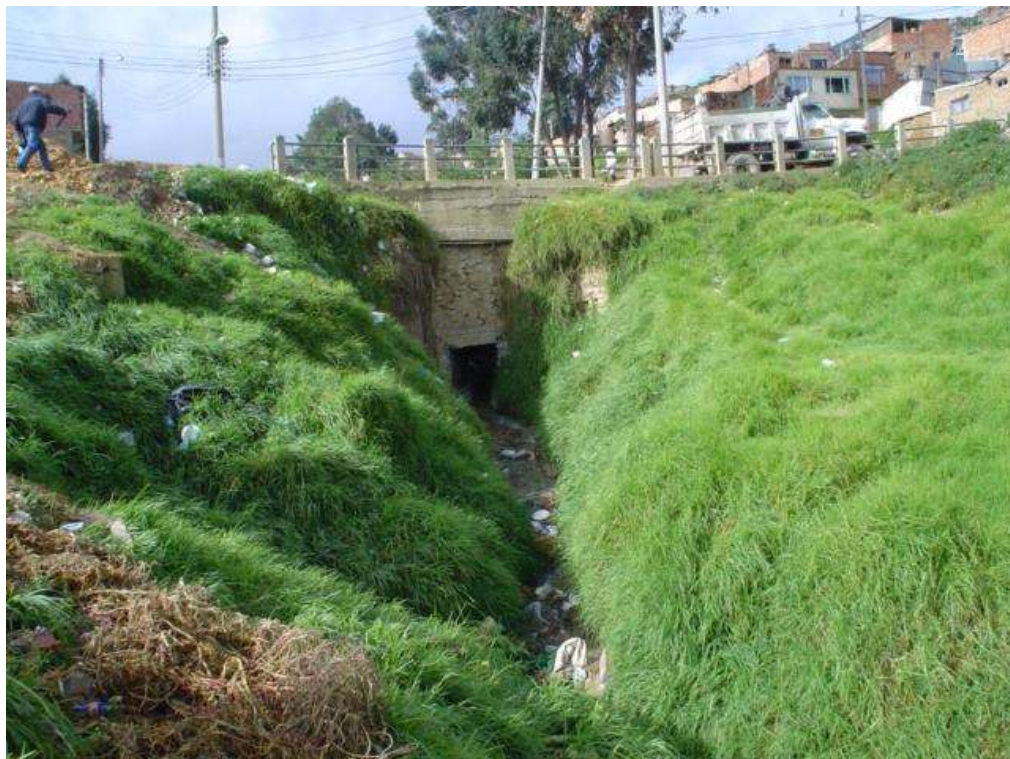
Fotografía 25. Canal de salida de la alcantarilla, el lecho está sobre roca.
