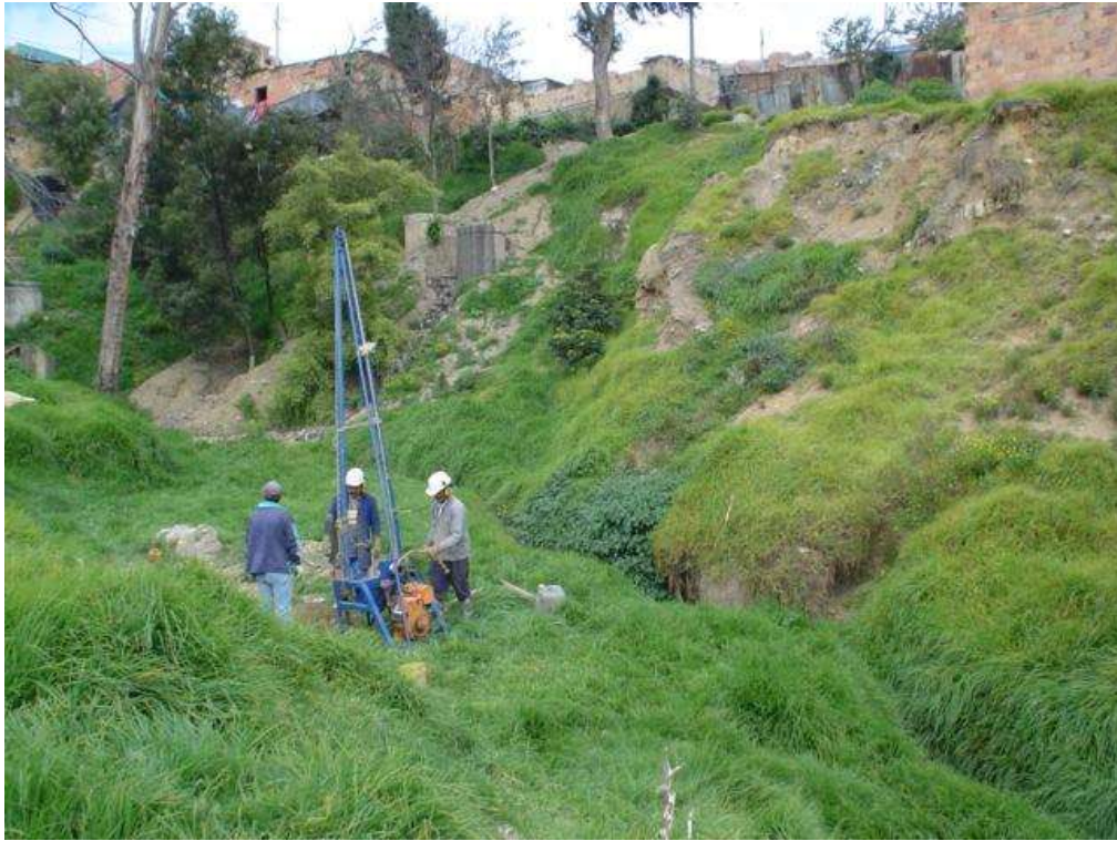
Fotografía 26. Área inestable en la margen izquierda del Zanjón.
