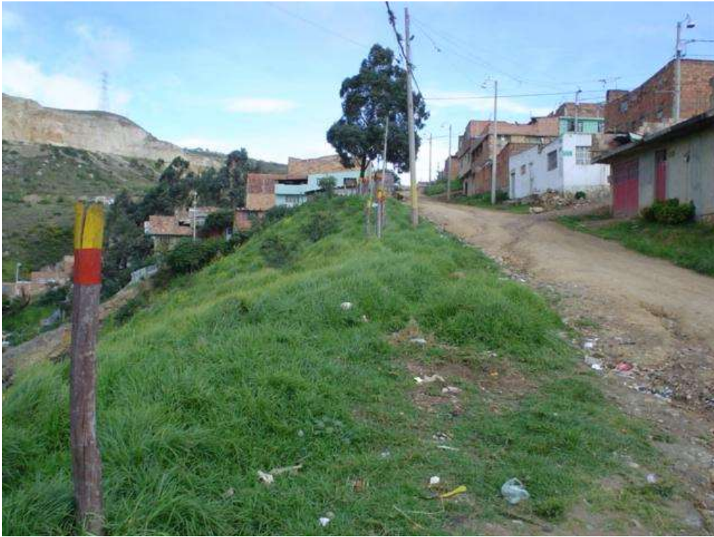
Fotografía 9. Parte superior del talud de la antigua explotación.
