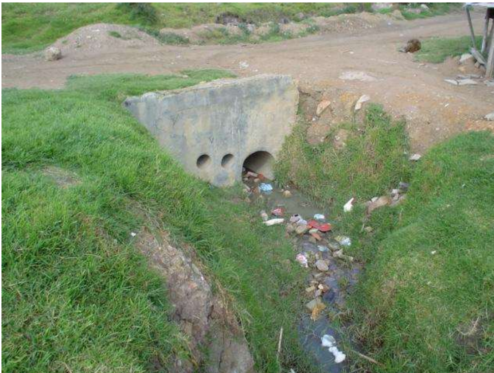
Fotografía 6. Salida de la alcantarilla.
