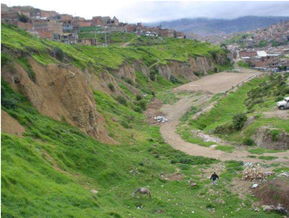
Fotografía 8. Talud de la antigua explotación; se observan apilamientos de escombros sin compactar.
