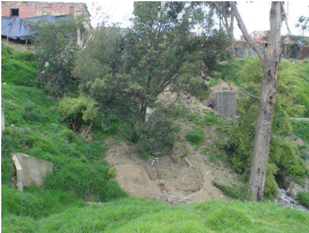
Fotografía 29. Zona inestable, que afectó unas viviendas del barrio El Triunfo, el pozo se encuentra desbordando agua por la tapa.
