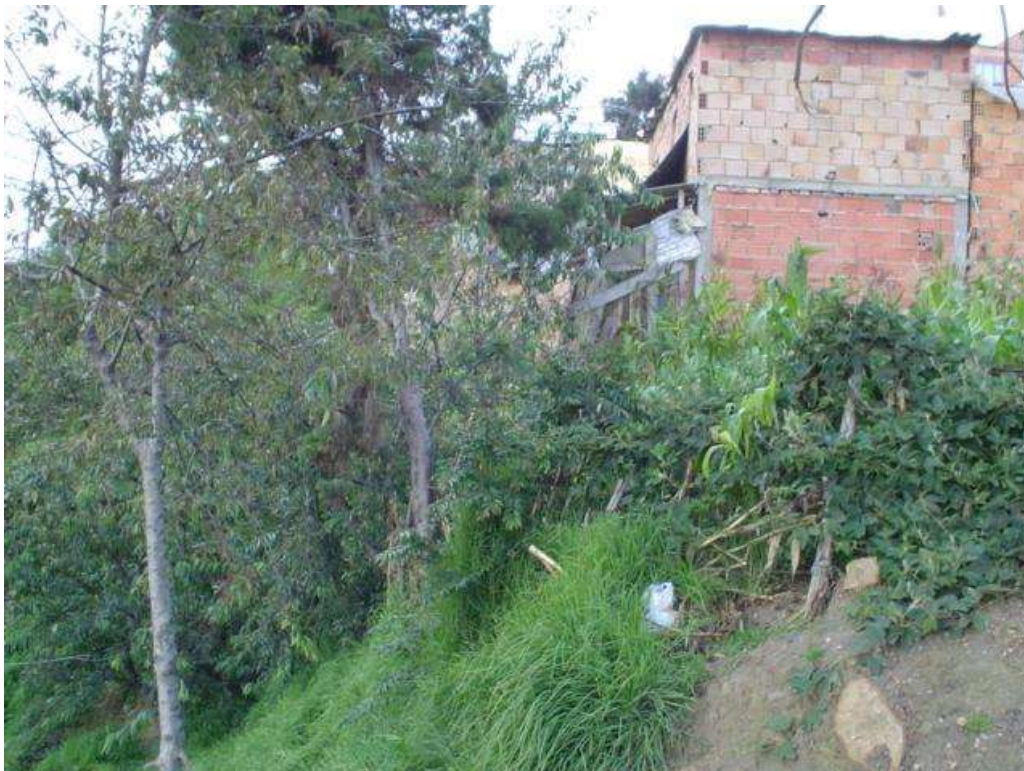
Fotografía 33. Hombro izquierdo del valle, al sur de la zona inestable.
