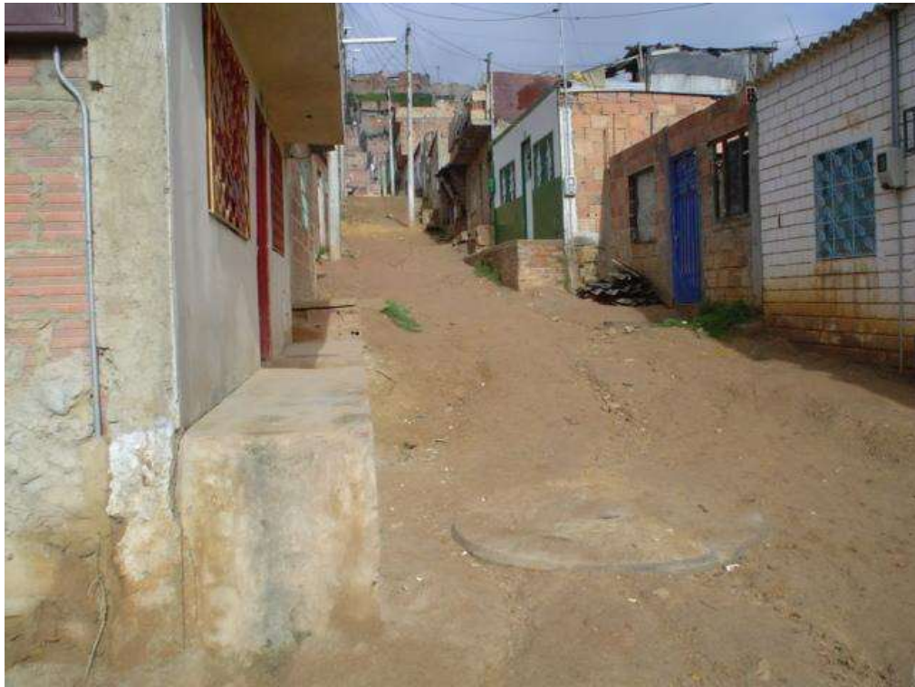
Fotografía 36. Calle 69 M Sur. Las viviendas se encuentran en buen estado.
