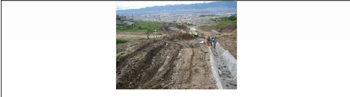
Tramo de canal 1 adelantado a la fecha
