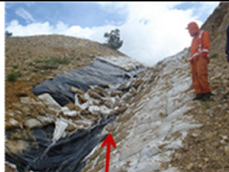
Estructura en gavión zona baja canal de la quebrada Santa Rita
