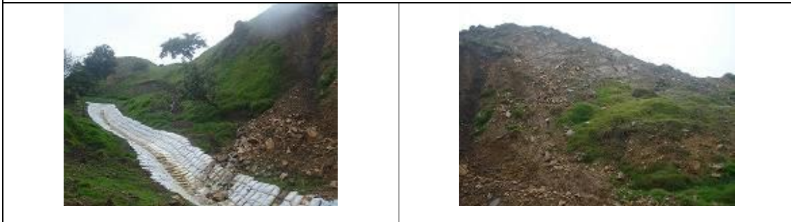
Flujo de detritos a la altura del K0+600 en canal de la quebrada Santa Rita
