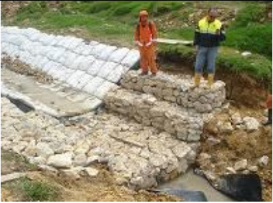
Estructura en gavión zona baja canal de la quebrada Santa Rita
