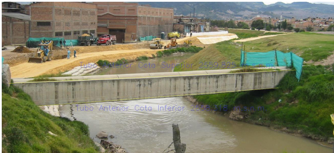
Ilustración 80. Tubo del sistema de bombeo de San Benito
