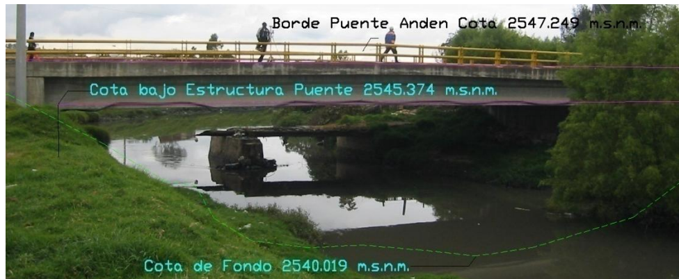
Ilustración 86. Puente San José
