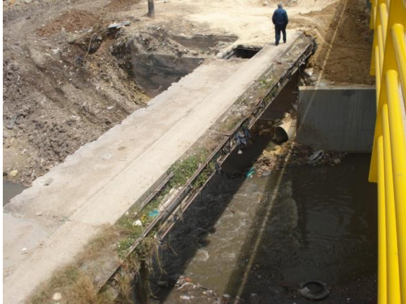
Foto 3. Estructura existente en el sitio del Puente sobre la quebrada Chiguaza con cra 16B
