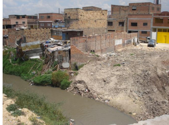
Foto 4. Vista hacia aguas abajo del puente existente sobre la Qda. Chiguaza en la Cra 16B.
