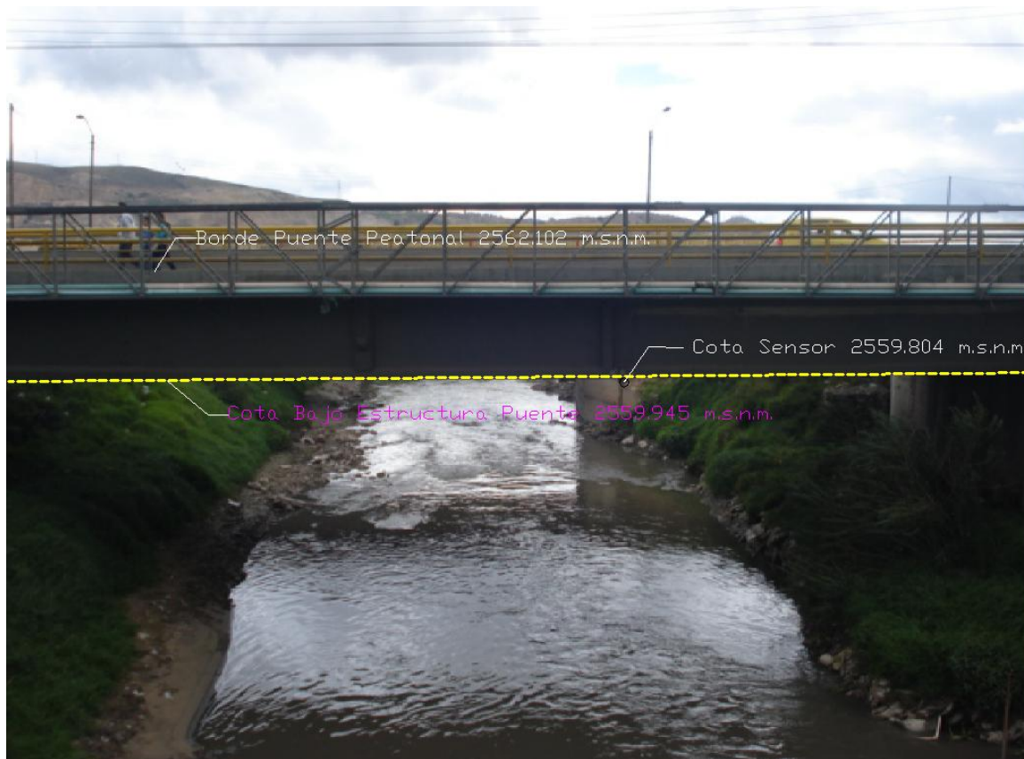
Ilustración 81. Puente sobre la Avenida Boyacá en el sector de San Benito
