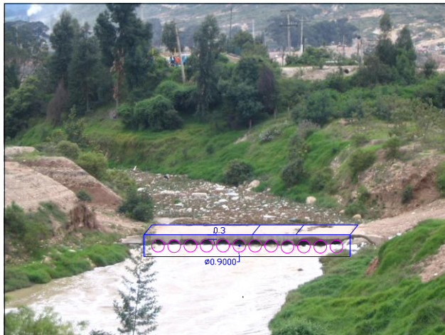
Ilustración 75. Vista del Puente de la Escuela de Artillería y dimensiones principales
