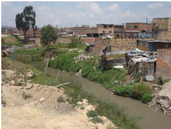
Foto 5. Vista de las viviendas localizadas en las banquetas de la Qda. Chiguaza en la confluencia con el río Tunjuelo.
