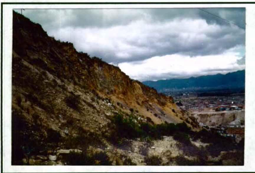
FOTO 24. ZONAS IA Y II. ASPECTO DEL MACIZO ROCOSO CORRESPONDIENTE AL ANTIGUO FRENTE DE LA CANTERA SANTA RITA Y QUE ESTA SEPARADO DE LA MANZANA K POR UNA DISTANCIA MÍNIMA DE 7 METROS. NÓTESE EL ASPECTO METEORIZADO DEL MACIZO ROCOSO, QUE EVIDENCIA SU ESTABILIDAD EN EL TIEMPO. LA CASA QUE SE VE EN HACIA EL EXTREMO INFERIOR DERECHO DE LA IMAGEN SE CONSTRUYÓ EN 1984, Y NO HA SIDO AFECTADA POR PROCESOS DE REMOCIÓN EN MASA, AUNQUE HAN EXISTIDO CAÍDAS PUNTUALES DE DETRITOS Y FRAGMENTOS ROCOSOS.
