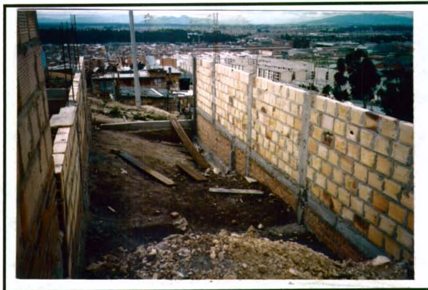
FOTO 14. CIMENTACIONES CON VIGA DE AMARRE EN LA MANZANA I. NÓTENSE LAS COLUMNAS A CONSTRUIR, CON CONCRETO Y ACERO Y LA RELACION DE LAS VIGAS CON LAS ZAPATAS.
