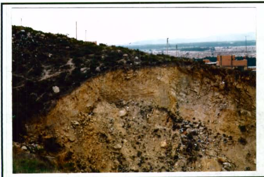
FOTO 28. DETALLE DEL MATERIAL AFECTADO POR EL FENÓMENO DE REMOCIÓN EN MASA DE LA ZONA IVB.
