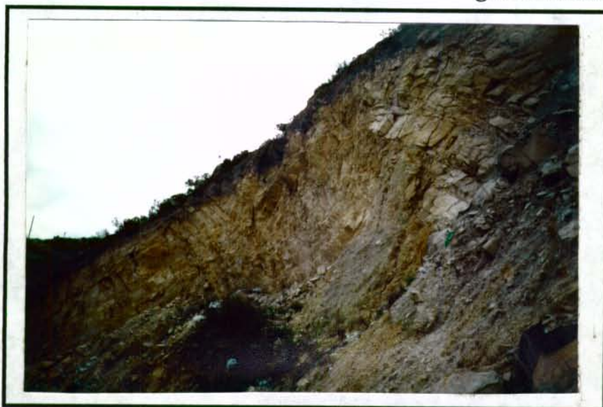
FOTO 7. ANTICLINAL DE SAN RAFAEL. NÓTESE LA FALLA QUE FRACTURA LA ROCA EN EL EJE DEL PLIEGUE.
