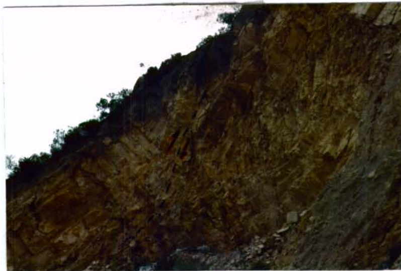
FOTO 8. ZONA CORRESPONDIENTE AL EJE FALLADO DEL ANTICLINAL DE SAN RAFAEL. ESTA FALLA ES DE CABALGAMIENTO Y DISMINUYE LAS PROPIEDADES GEOMECÁNICAS DE LA ARENISCA, POR EL FRACTURAMIENTO A QUE ES SOMETIDO EL MATERIAL ROCOSO. ESTA ZONA FALLADA SE HALLA POR FUERA DEL ÁREA QUE INFLUENCIA LA MANZANA K O CUALQUIER OTRA ZONA URBANIZABLE DEL BARRIO SAN RAFAEL (ZONA V).
