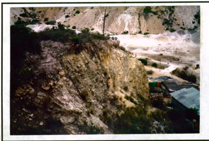
FOTO 13. A PESAR DEL FRACTURAMIENTO DEL MACIZO ROCOSO, LA CASA QUE SE OBSERVA EN EL EXTREMO DERECHO DE LA IMAGEN SE ENCUENTRA CONSTRUIDA AL MENOS DESDE 1974 Y NO HA SIDO AFECTADA POR LA CAÍDA DE BLOQUES, LO QUE EVIDENCIA QUE SI BIEN ESTE TIPO DE MOVIMIENTO ES ACTIVO, ES PUNTUAL Y DE BAJA AMENAZA. OBSÉRVESE EL ANTICLINAL DE SAN RAFAEL, DONDE LOS BUZAMIENTOS DE LA PARTE DERECHA SE DIRIGEN HACIA LA DERECHA, MIENTRAS QUE LOS DE LA PARTE IZQUIERDA BUZAN EN LA DIRECCIÓN OPUESTA.
