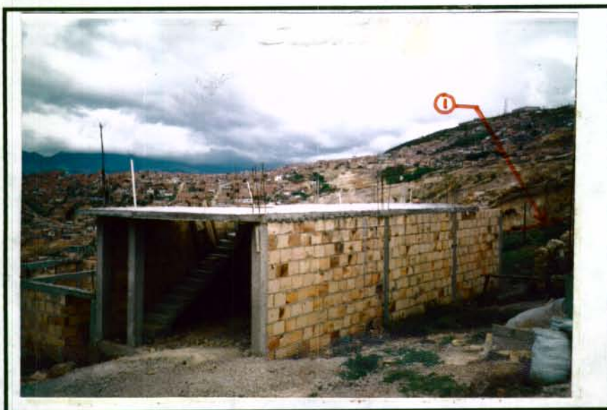
FOTO 30. PLANCHA PARA EL SEGUNDO PISO (MANZANA K). NÓTESE LA DISTANCIA AL ESCARPE (1) QUE CONSTITUYE LA ZONA IA; LA VULNERABILIDAD FÍSICA ACTUAL ES BAJA, PERO SI LAS CONSTRUCCIONES AVANZAN HACIA EL ESCARPE, LA VULNERABILIDAD AUMENTARÁ, RAZÓN POR LA CUAL SE PROPONE LA CONSTRUCCIÓN DE UN MURO QUE IMPIDA DICHA SITUACIÓN.
