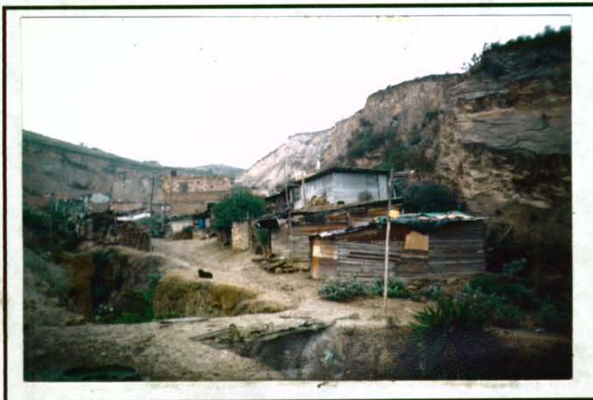
FOTO 25. SEGÚN LA INTERPRETACION CINEMÁTICA DE ESTA ZONA, LA PROBABILIDAD DE FALLAS PLANARES ES BAJA PUES EL ÁNGULO DE ESTRATIFICACIÓN ES MAS BAJO QUE EL ANGLULO DE FRICCIÓN. (ZONA IIB).
