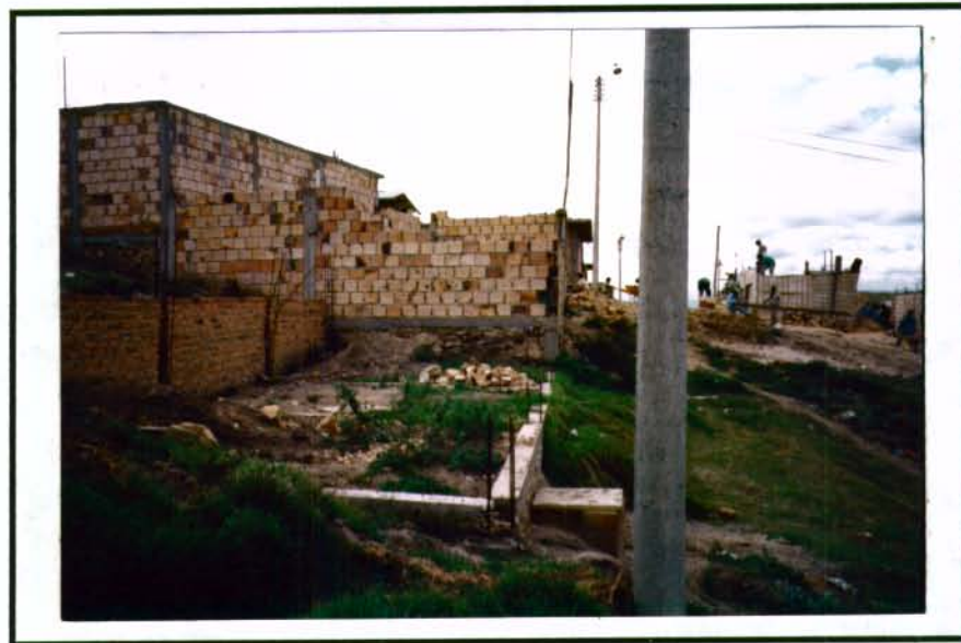
FOTO 16. DETALLE DE CIMENTACIÓN DE VIVENDAS, CON REFUERZO DE LA BASE EN LADRILLO PENSADO
