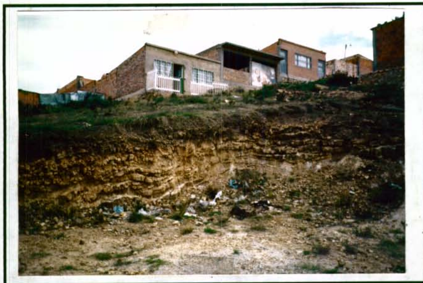
FOTO 31. LA CIMENTACIÓN DE LA FUTURA VIVIENDA A CONSTRUIR SE ENCUENTRA DIRECTAMENTE SOBRE UN NIVEL ROCOSO DE BUENAS CARACTERÍSTICAS GEOTÉCNICAS (ZONA VIIB).
