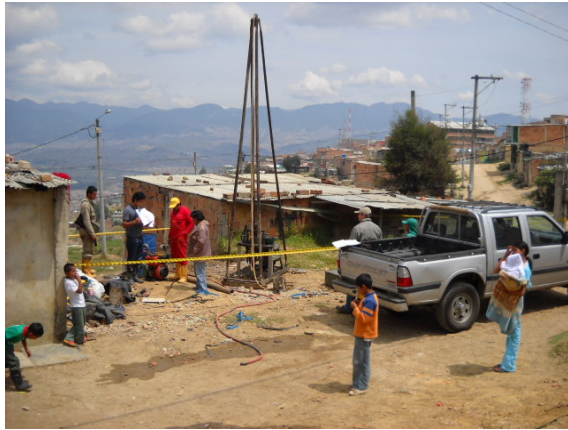
Fotografía 1-8 Instalación de inclinómetro.
