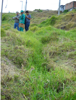
Fotografía 1.4. Vista general de las grietas identificadas en la zona de la Carbonera.
