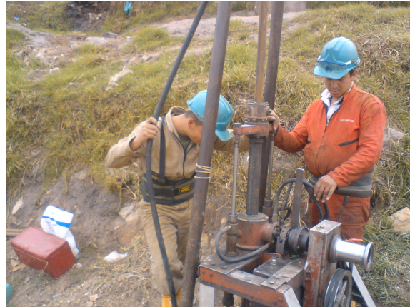
Fotografía 1-9 Instalación de piezómetro.
