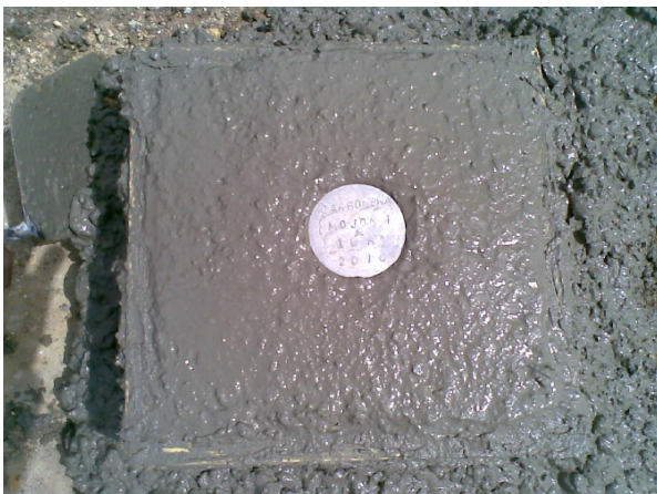
Fotografía 1-6 Instalación de mojón georeferenciado
