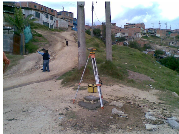
Fotografía 1-7. Georeferenciación de mojón utilizando GPS.
