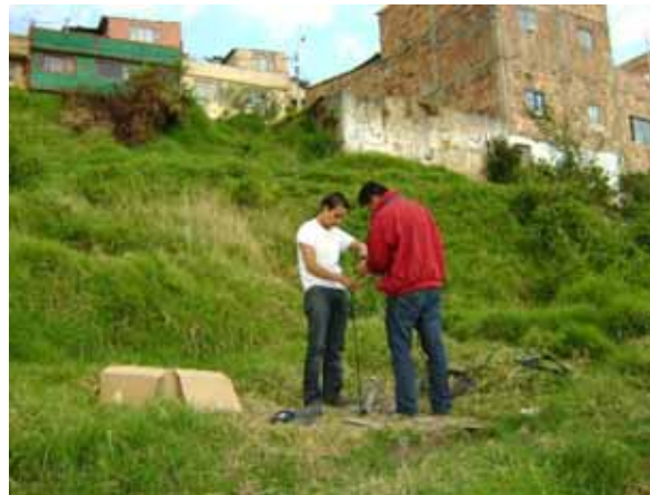
Fotografía 8-4 Inclinómetro ubicado en la perforación S-4
