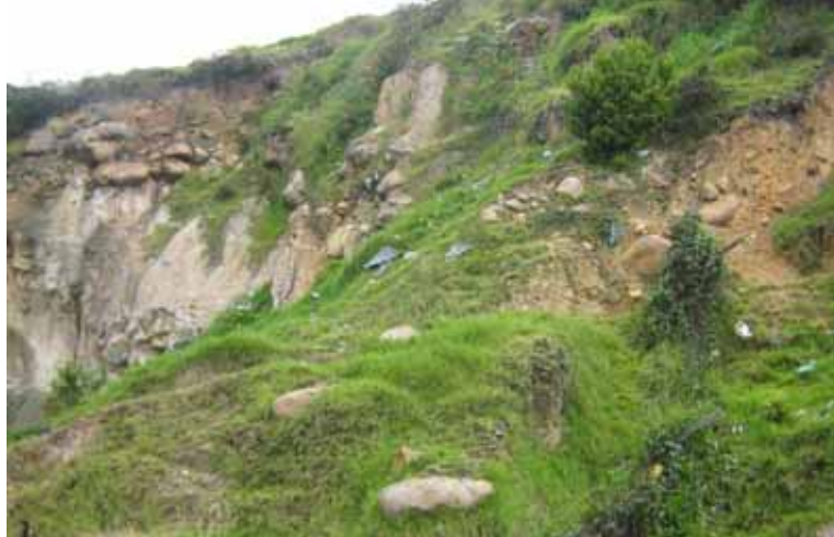
Fotografía 6-1 Antigua frente explotación de materiales
