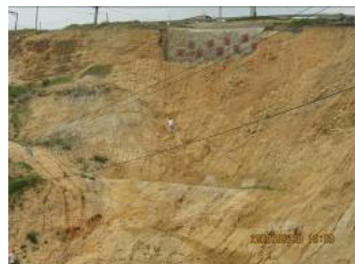
Fotografía 10. Evidencia del avance de procesos de erosión en surcos y laminar, se alcanzan a presentar pequeñas cárcavas.
