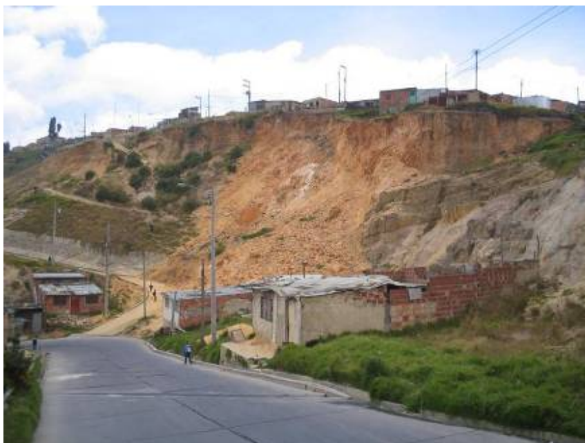
Fotografía 17 Laderas intervenidas por actividades extractivas y taludes mecanizados producidos por la intervención antrópica, relacionada con la extracción de materiales de construcción. (Tomado de IGR-2006)
