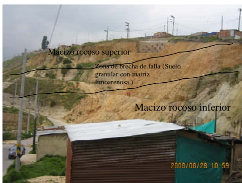
Fotografía 9. Vista general del sitio de estudio luego de la implementación de las obras de estabilización en la primera fase, esta vista corresponde con la condición actual.
