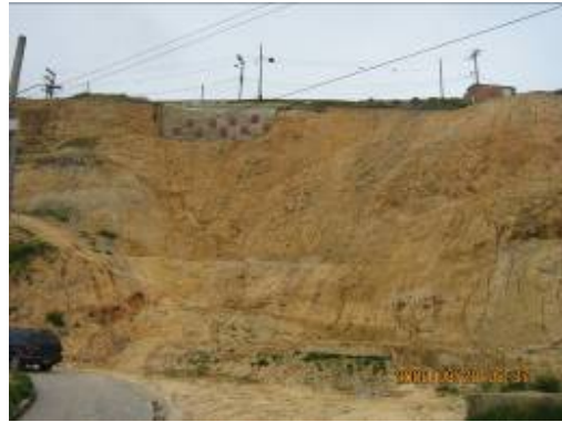
Fotografía 2. Vista del talud con la pantalla anclada y en la condición morfológica actual.
