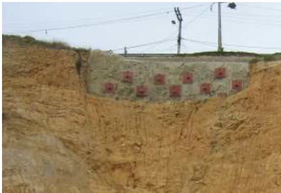
Fotografía 3. Vista de la pantalla anclada en primer plano
