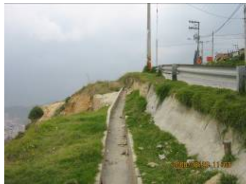
Fotografía 4. Cuneta de la parte alta construida en conjunto con la pantalla.
