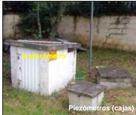
Fotografía 13. Detalle de ubicación y estado de piezómetros – Universidad Agraria.
