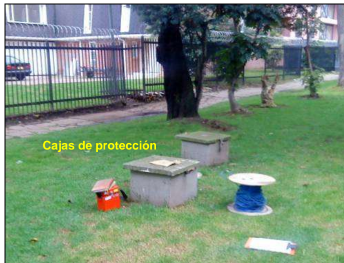
Fotografía 10. Detalle de ubicación y estado de piezómetros – Calle 127Bis – Cra. 20.
