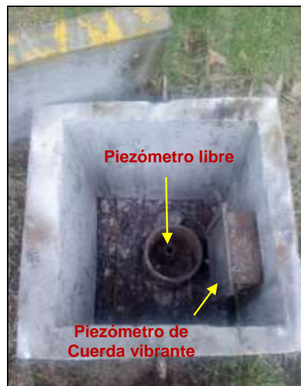
Fotografía 16. Distribución de los piezómetros – Aeropuerto El Dorado CNA.
