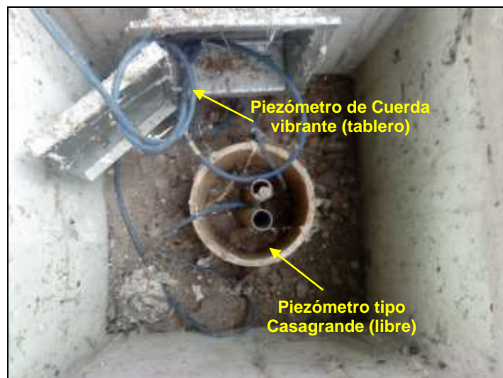
Fotografía 11. Distribución de los piezómetros instalados – Calle 127Bis – Cra. 20.
