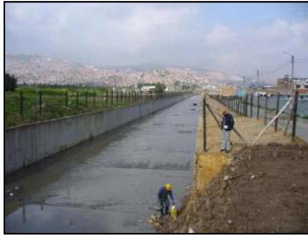
Fotografía No. 26. Dragado, limpieza y canalización del corredor de la Quebrada Chiguaza
