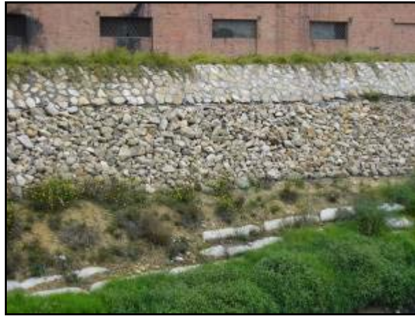
Fotografía No. 27. Realce de jarillón Heterogéneo Barrio San Benito
