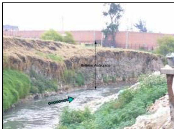
Fotografías No. 20 y 21. Talud de margen izquierdo Río Tunjuelito con recubrimiento en tierra Localidad de Kennedy
