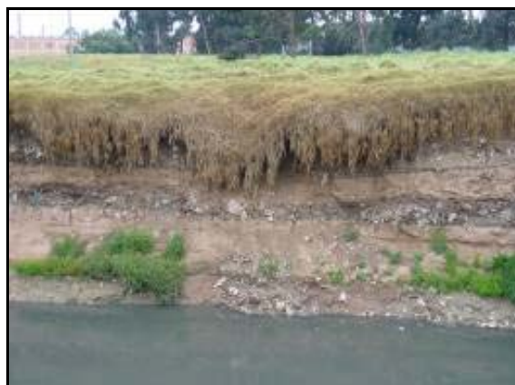
Fotografías No. 20 y 21. Talud de margen izquierdo Río Tunjuelito con recubrimiento en tierra Localidad de Kennedy
