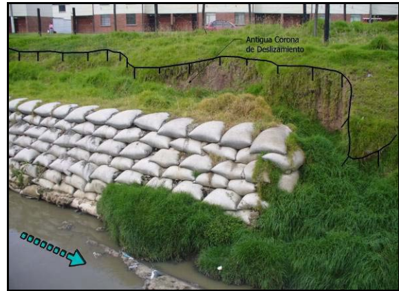
Fotografías No. 10 y 11 Paso del puente en concreto y aguas abajo protección deslizamiento rotacional
