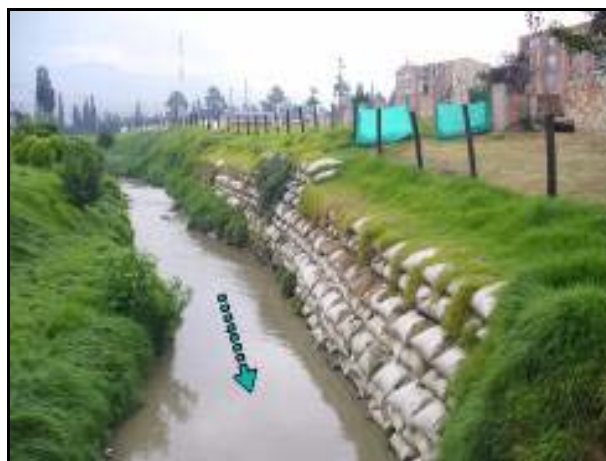
Fotografía No. 9 Obras de protección para el puente de acceso a viviendas de la Guarnición Militar
