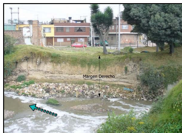
Fotografías No. 5 y 6. Inclinación del muro en gavión y excavación antrópica sobre la margen derecha
