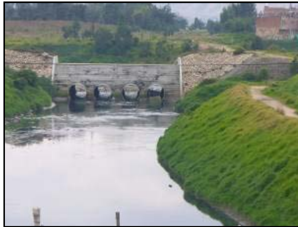
Fotografía No. 28. Estructura de restricción de caudales sobre el lecho del Río Tunjuelo
