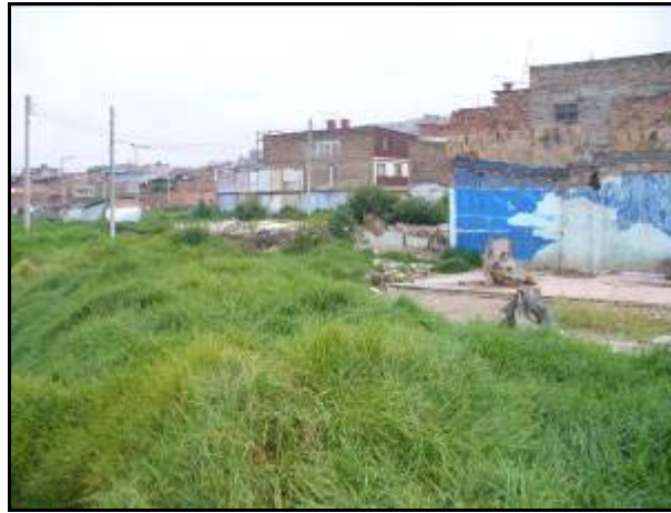
Fotografía No. 29. Recuperación ronda hidráulica Quebrada Chiguaza a la altura del barrio Abraham Lincoln
