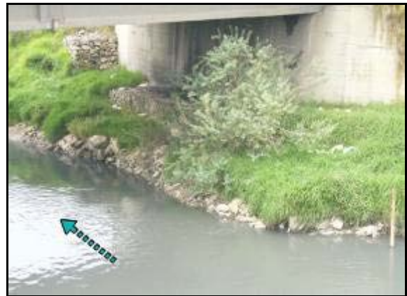
Fotografías No. 15 y 16. Realce de jarillón y pantalla en gavión en mal estado
