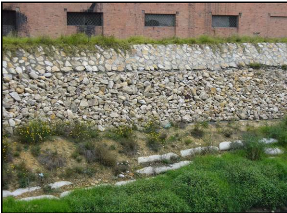
Fotografías No. 15 y 16. Realce de jarillón y pantalla en gavión en mal estado
