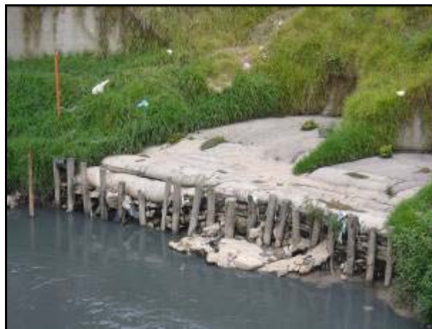
Fotografía No. 17. Bolsacreto protegido mediante empalizada artesanal
