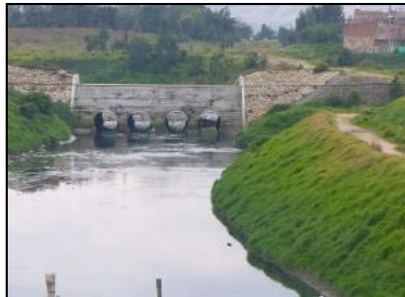
Fotografías No. 32 y 33. Estructura de control de caudales
