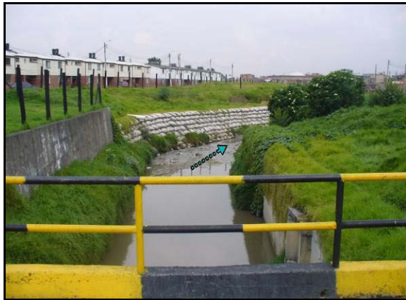
Fotografías No. 10 y 11 Paso del puente en concreto y aguas abajo protección deslizamiento rotacional
