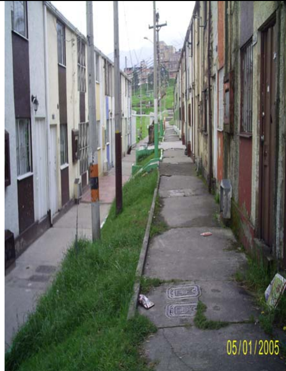
Foto No. 5 Construcción que conservan su tipología. Tipo 1.
