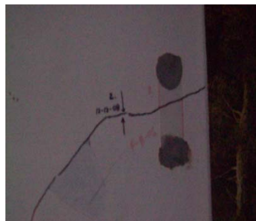
Foto No. 14 Testigo sobre muro.
