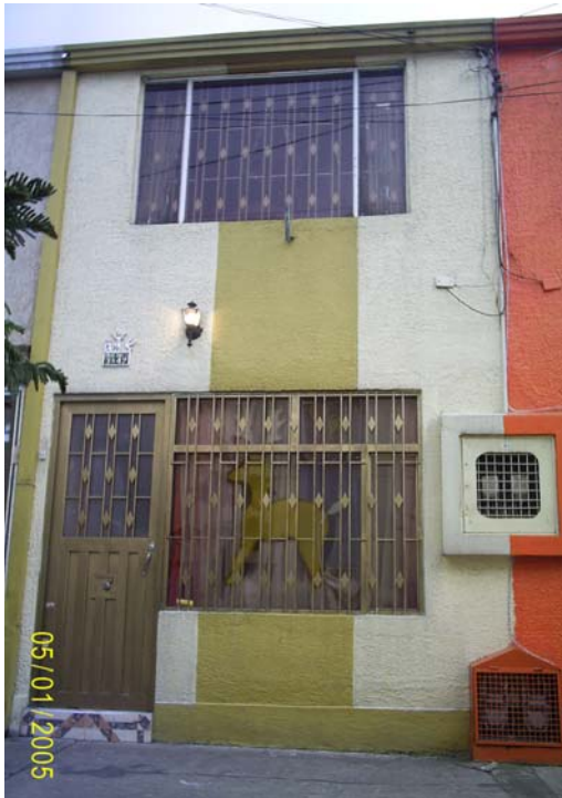
Foto No. 4 Construcción que sufrió modificaciones. Tipo 2.
