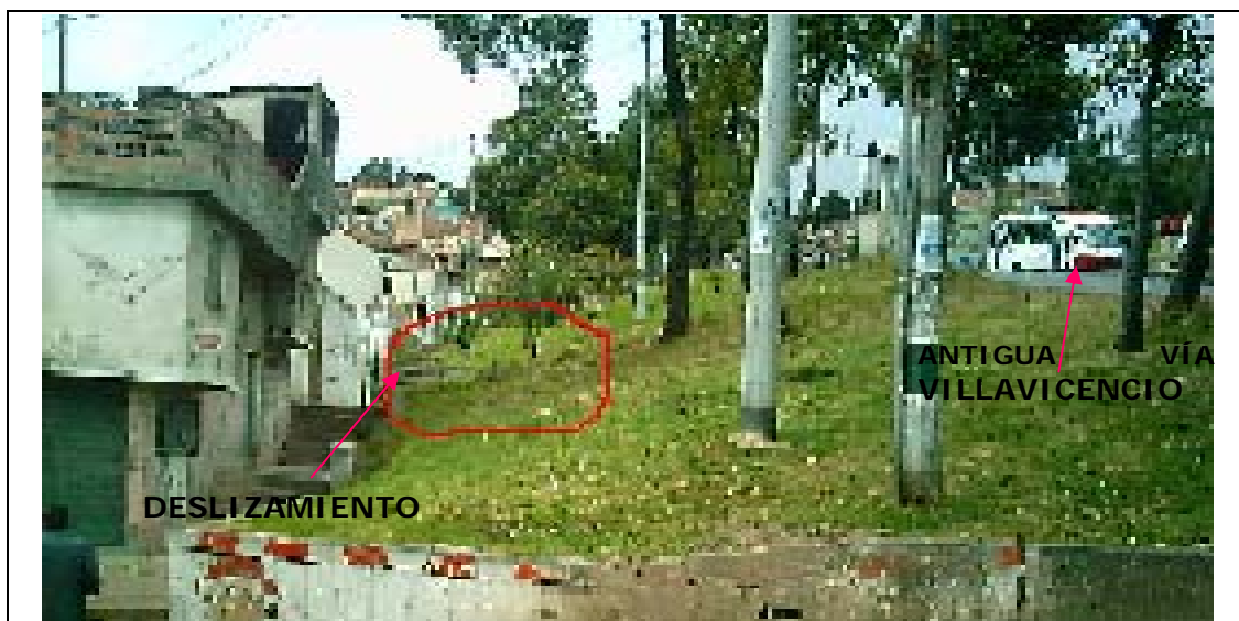
Foto No. 1. Deslizamiento del sector sur-oriental de (Zona 4) Villa de los Alpes.
