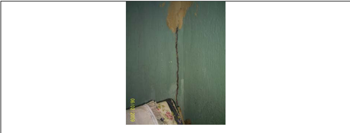
Foto No. 34 Grieta en muro.
