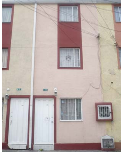
Foto No. 10 Fachada.
