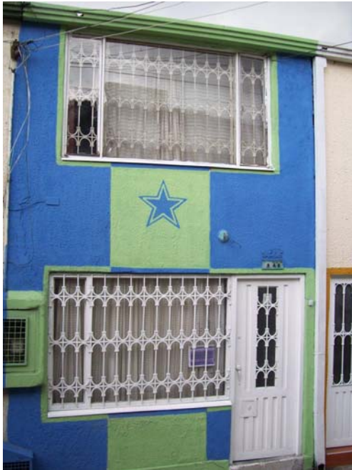
Foto No. 2 Construcción Tipo 2. Vivienda modificada.
