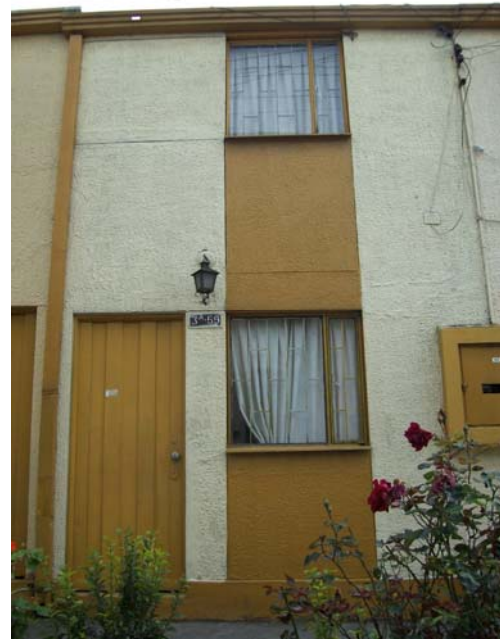
Foto No. 3 Construcción Tipo 1. Vivienda sin modificaciones.
