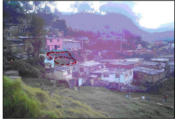
Fotografía 10 Visual general del movimiento en abril de 2006. Se puede observar que el movimiento a continuado y parte del material en la corona colapsó dejando ver un escarpe de 1.85 metros de profundidad.
