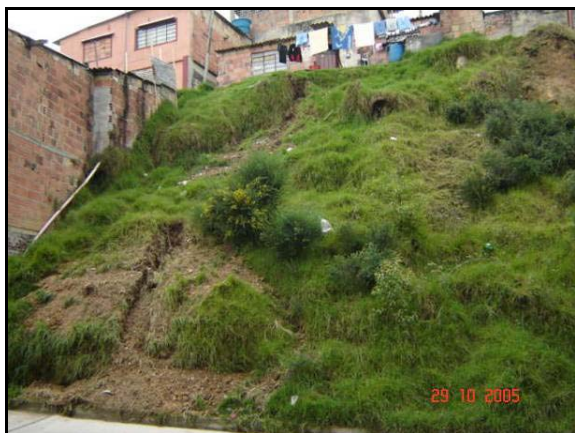
Fotografía 1: Deslizamiento que se presentó en 1989 en el zona nor-oriental del área de estudio, justo en frente del predio de la señora Blanca Balboa Sanabria. La cicatriz de falla fue cubierta con relleno de basuras y en la base se formó una lengüeta que invadió la vía en la parte baja.
