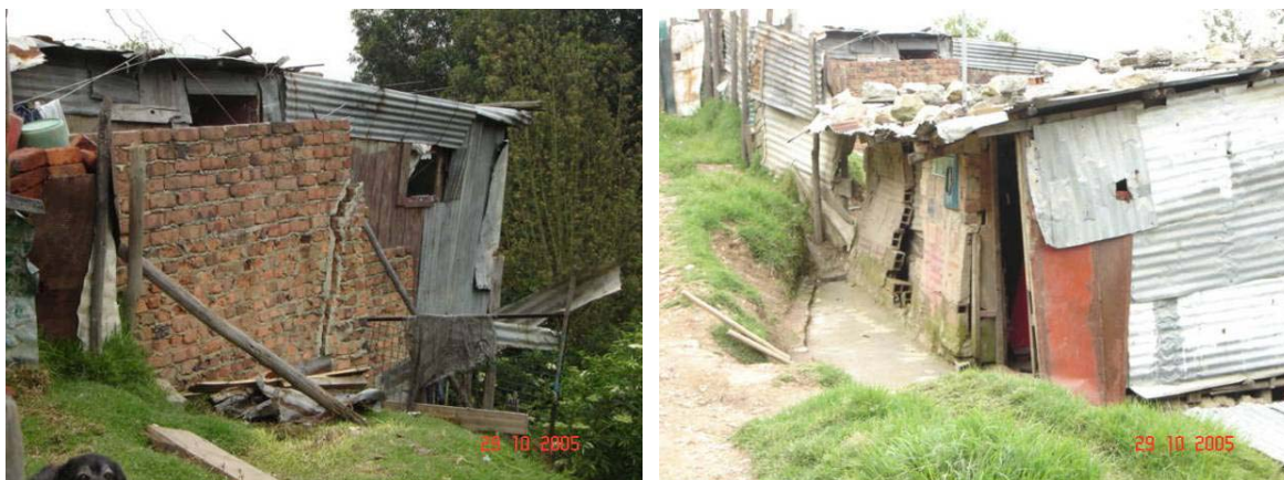
Fotografía 7 y 8 Casas localizadas detrás del borde externo de la banca sobre la diagonal 25 sur, después del deslizamiento principal. La acumulación de agua en el suelo ha generado fallas superficiales sobre una capa delgada de coluvión, generando grietas en las casas del sector.
