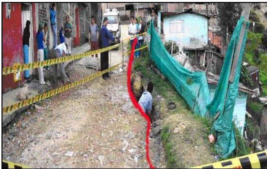
Fotografía 11. A finales del año 2005 (diciembre), en la zona central del área de estudio. Se genero un movimiento que afecto la un vía de acceso al barrio Ramajal. En la fotografía se resalta una grieta en la corona del movimiento.
