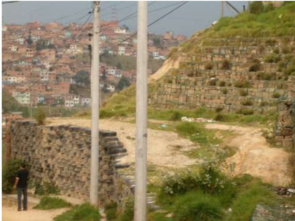
Foto 8: Muro en llantas funcional (Barrio Villas del Recuerdo - Rafael Uribe Uribe)
