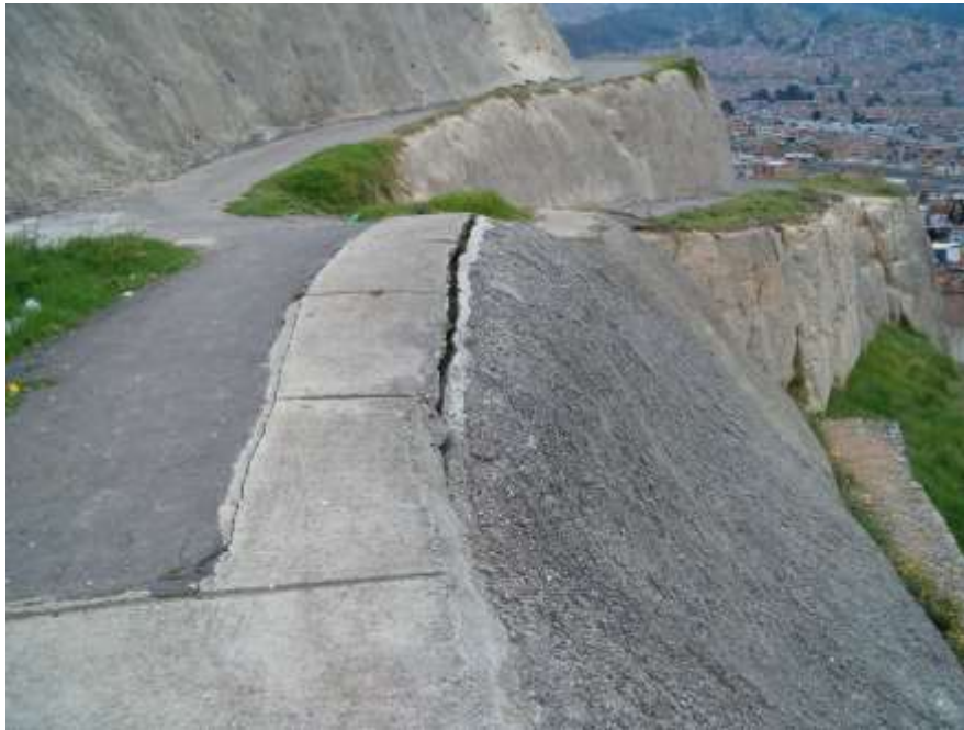
Foto 5: Sector para sellado de grietas (Playón Playitas – Rafael Uribe Uribe)
