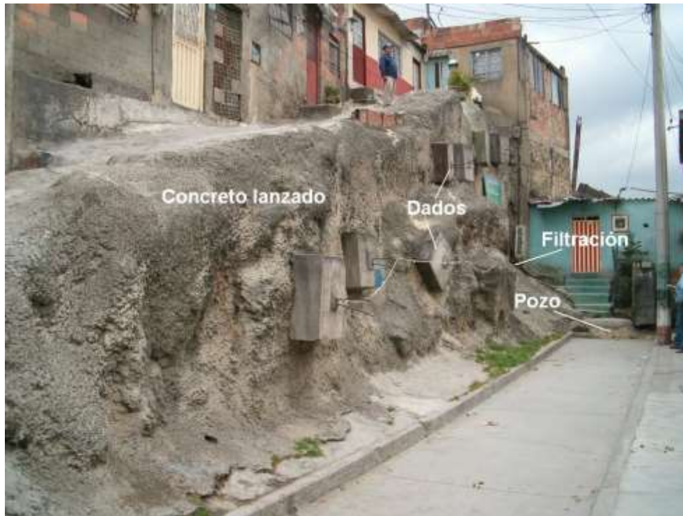
Foto 7: Sistema de anclaje con malla y concreto lanzado
