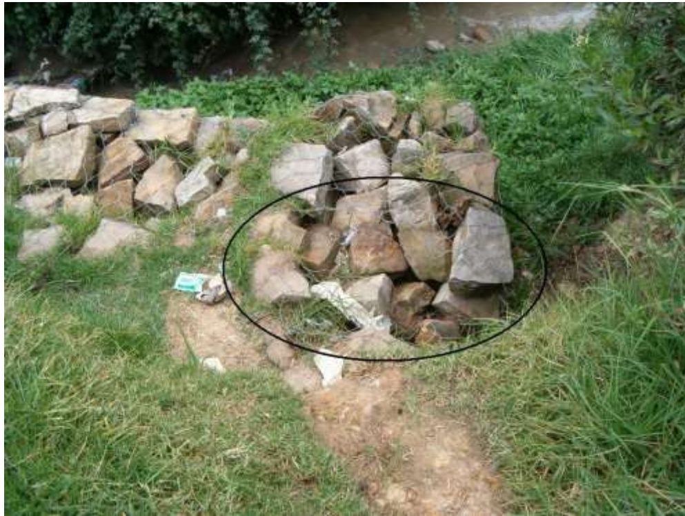
Foto 6: Sector para reparación de malla de gaviones (Barranquillita – Usme)
