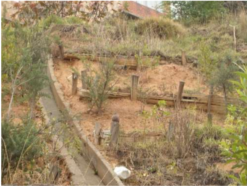
Foto 3: Trinchos fallados (Arborizadora Alta - Ciudad Bolívar)
