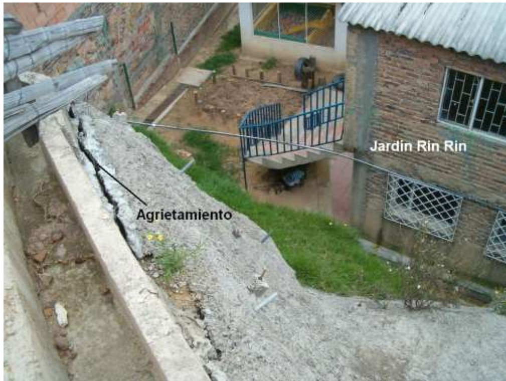
Foto 1: Falla del sistema de protección en la interfaz con otro sistema (Los Chircales – Rafael Uribe Uribe)
