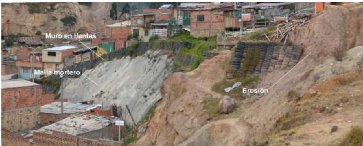
Foto 9: Muro en llantas con fallas. (San Joaquín del Vaticano - Ciudad Bolívar)
