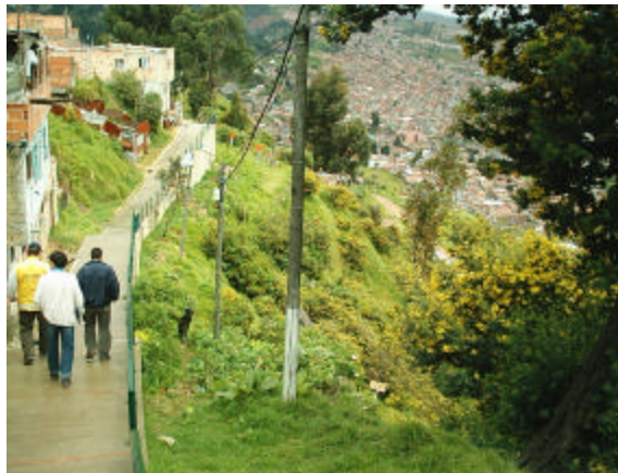
Fotografía 1 Emplazamiento del muro de contención
