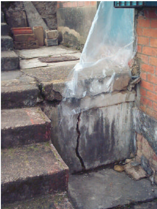
Fotografía No. 10 (Izquierda). Fisuras en muro de andén de la calle 42 Sur
