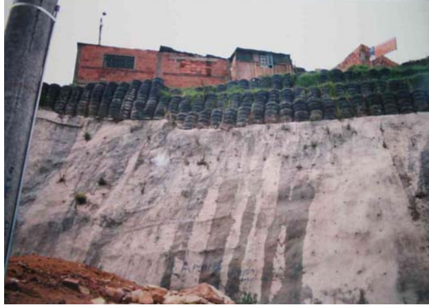
Fotografía 1 Obras de Estabilización Propuestas por IGL (2000)
