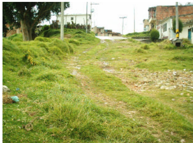
Fotografía 3 Ubicación de las viviendas y las vías
