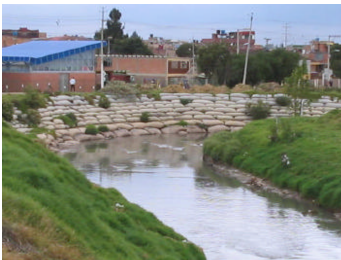
FOTOGRAFIA 2. Utilización de Bolsacretos hacia aguas abajo del deslizamiento
