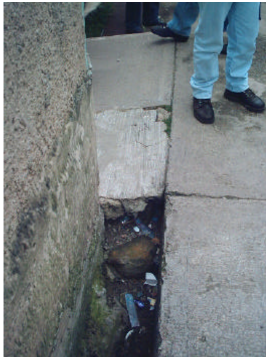
Fotografía No. 10 (Izquierda). Fisuras en muro de andén de la calle 42 Sur
