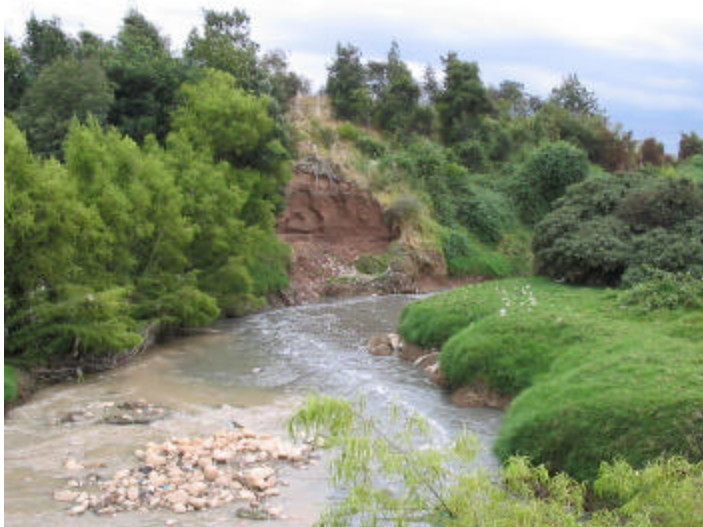
FOTOGRAFIA 1. Deslizamiento en la confluencia de la Quebrada Trompetas y el Río Tunjuelito
