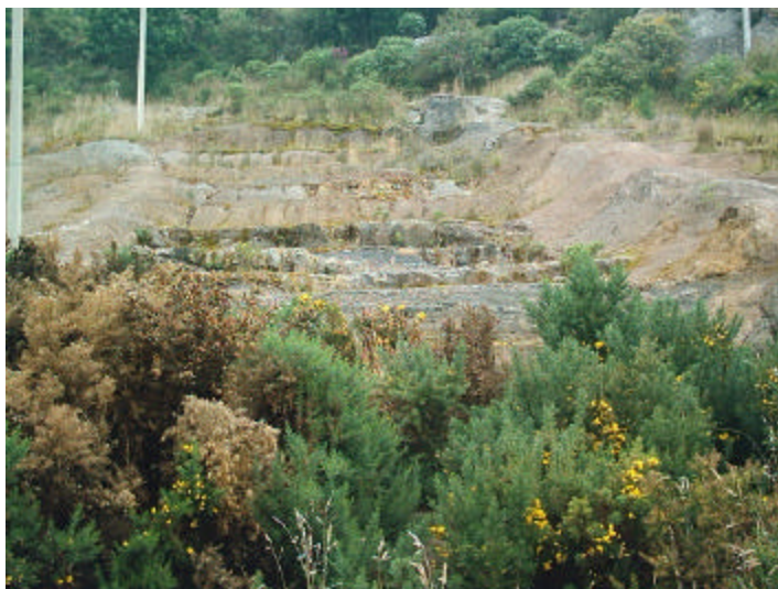
Fotografía No. 2. Terraceo abandonado en la parte superior del lote, vista hacia el oriente
