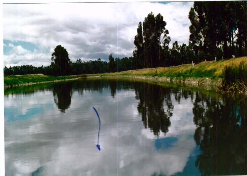
Fotografia No.39: Tramo 36-37. K12+200. Jarillones en buenas condiciones.
