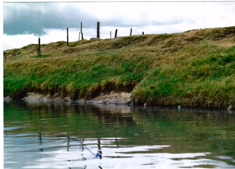
Fotografía No.17: Curva No.14. K7+500. Se observa erosión menor en la base del talud al inicio de la curva.
