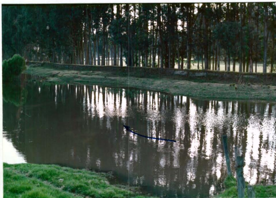
Fotografía No.96: Tramo 157-158 (Curva 89). K49+800. Detalle jarillón derecho. Se observa que la corona del jarillón es bastante delgada.
