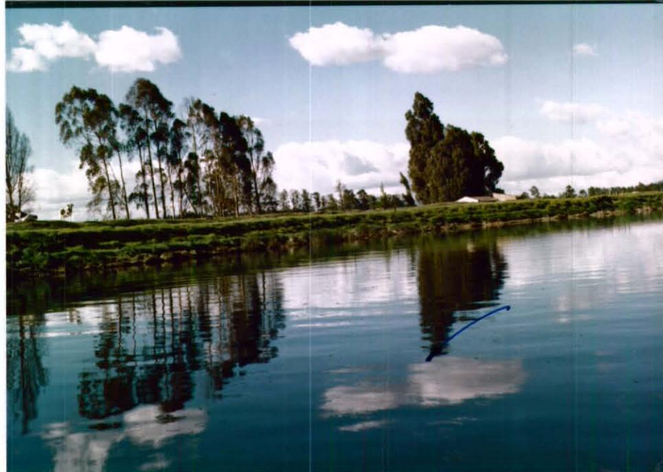
Fotografía No.69: Tramo 58-59 (Curva 36). Se observan signos de inestabilidad en el jarillón derecho producto de la erosión en la base.
