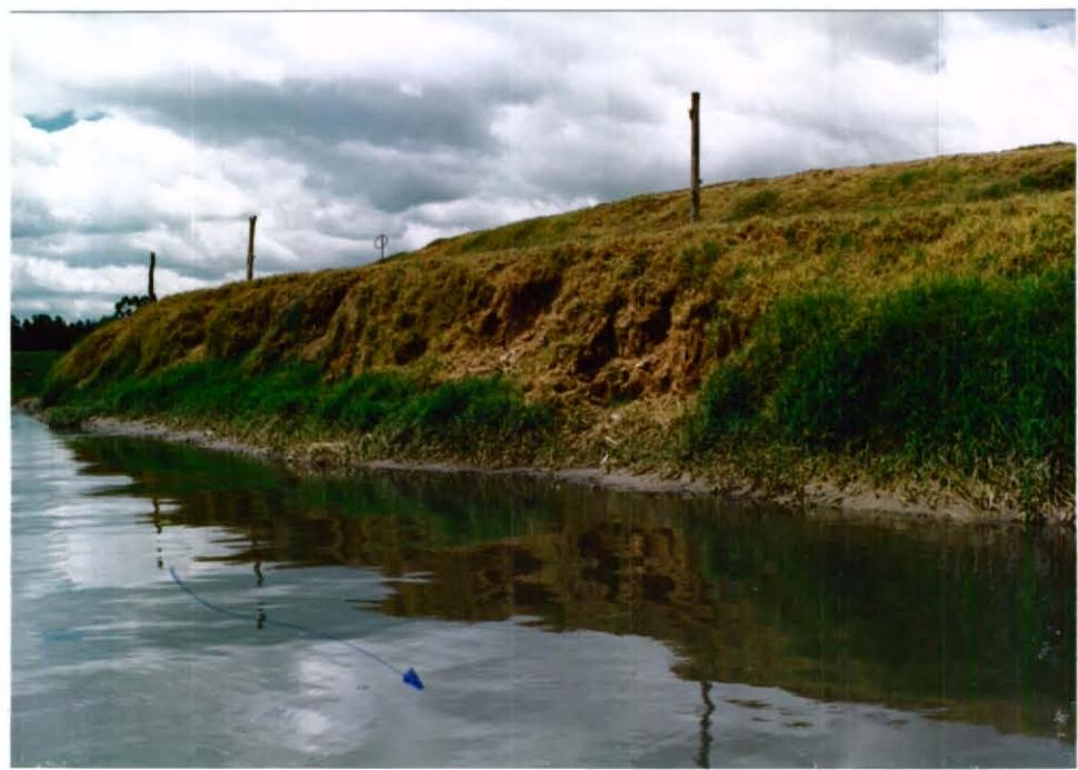
Fotografía No.18: Curva No.14. K7+500. El talud del jarillón izquierdo al final de la curva se hace algo vertical.
