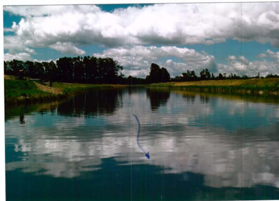
Fotografía No.37: Tramo 34-35. Jarillones en buenas condiciones.
