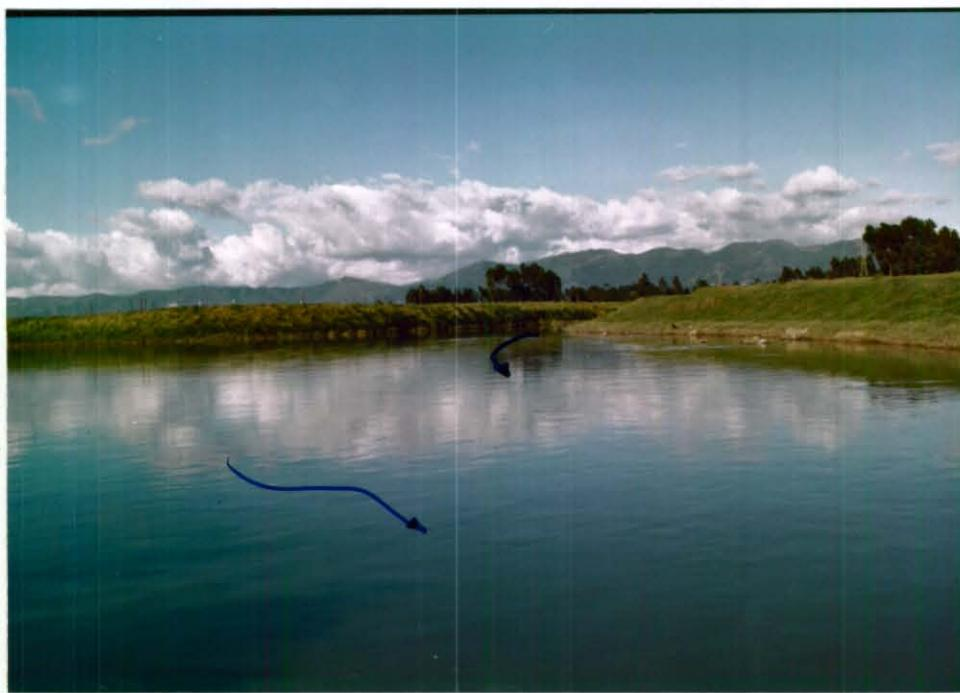
Fotografía No.86: Tramo 78-79 (Curva 45). Se observa confluencia del río fucha. En el jarillón izquierdo aguas arriba, deja de tener berma intermedia.
