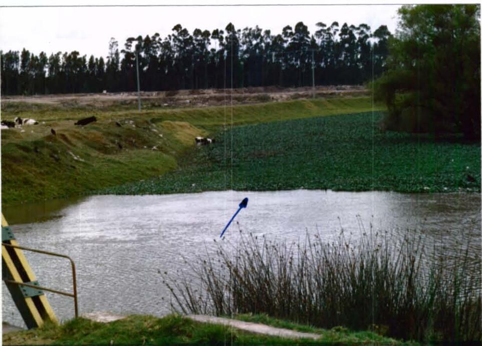
Fotografía No.114: Tramo 178-179. K55+100. Puente La Virgen. Se observa jarillón izquierdo en buenas condiciones. Río con abundante buchón y al fondo zona de construcción de relleno. (Vista hacia aguas abajo).
