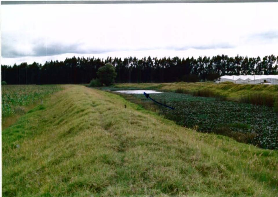
Fotografía No.98: Tramo 166-167 (Curva 95). K51+600. Detalle del jarillón izquierdo, el cual se encuentra en buen estado.
