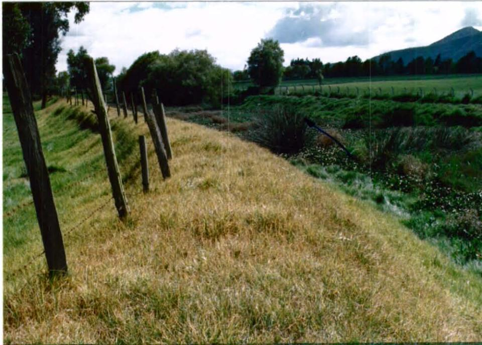
Fotografía No.107: Tramo 172-173. K53+400. Vista hacia aguas abajo. Se observa jarillón izquierdo en buenas condiciones mientras que el derecho no está muy bien conformado.
