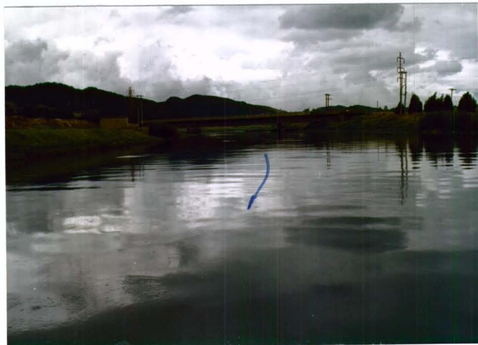
Fotografía No.13: Tramo 18-19. K5+500. Jarillones en buen estado. Se observa puente que comunica con el municipio de soacha y línea de alta tensión.
