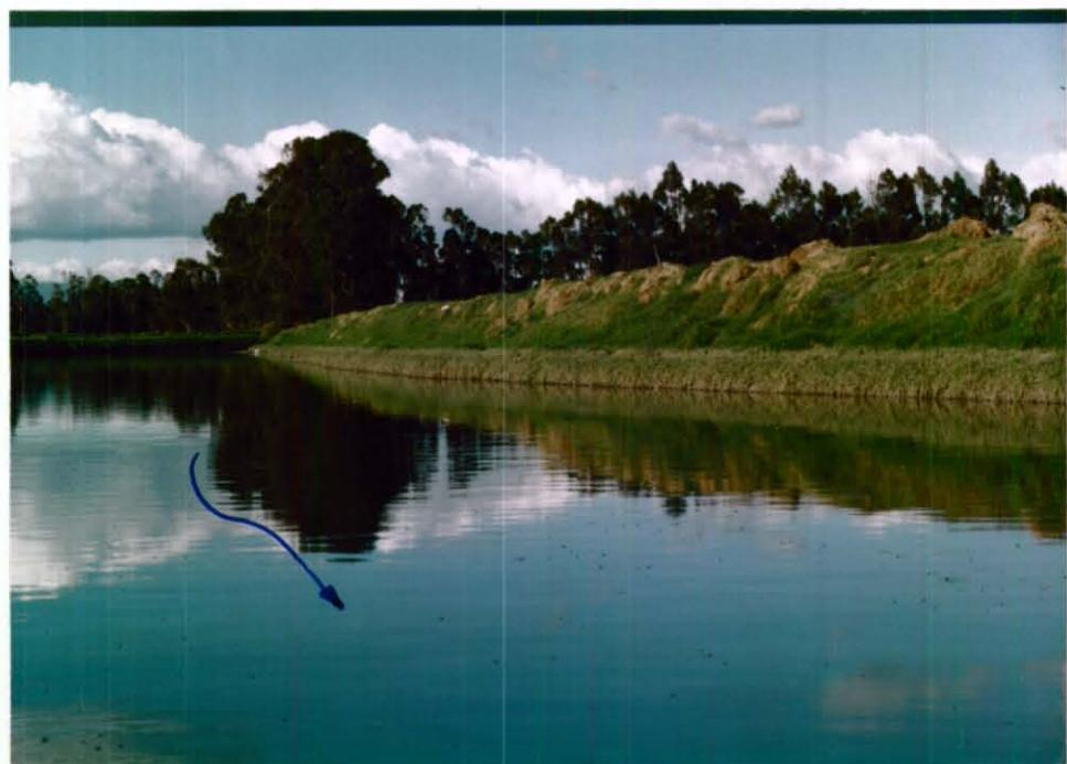
Fotografía No.80: Tramo 68-69. Detalle jarillón izquierdo. (Sin berma).
