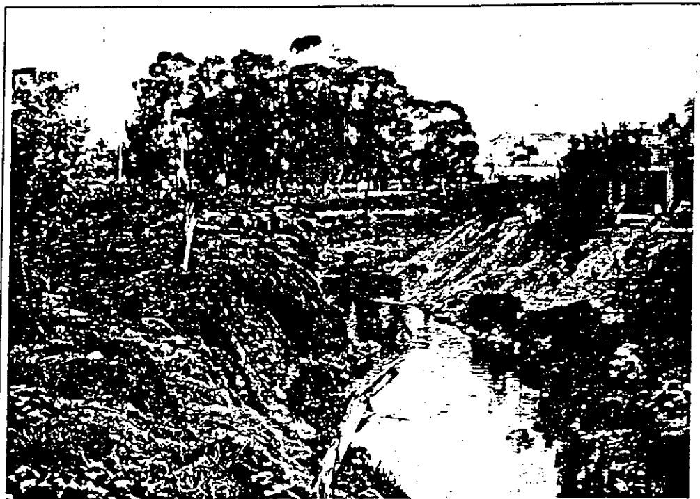
Fotografía # 10: Vista de la erosión existente en la curva externa en el margen del río K15+800. (HE-577-2135-12)
