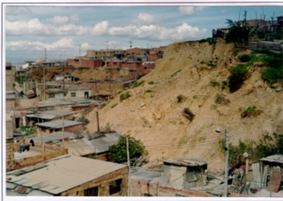
ROLLO 9047 Barrio Juan Pablo II – Barrio La Esperanza FOTO 36 Casas construidas en zonas inestables y en roca no consolidada
