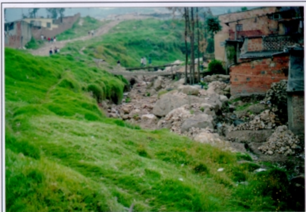
ROLLO 8013 Quebrada el Zuque FOTO 17 Gran cantidad de material arrasado por la Quebrada
