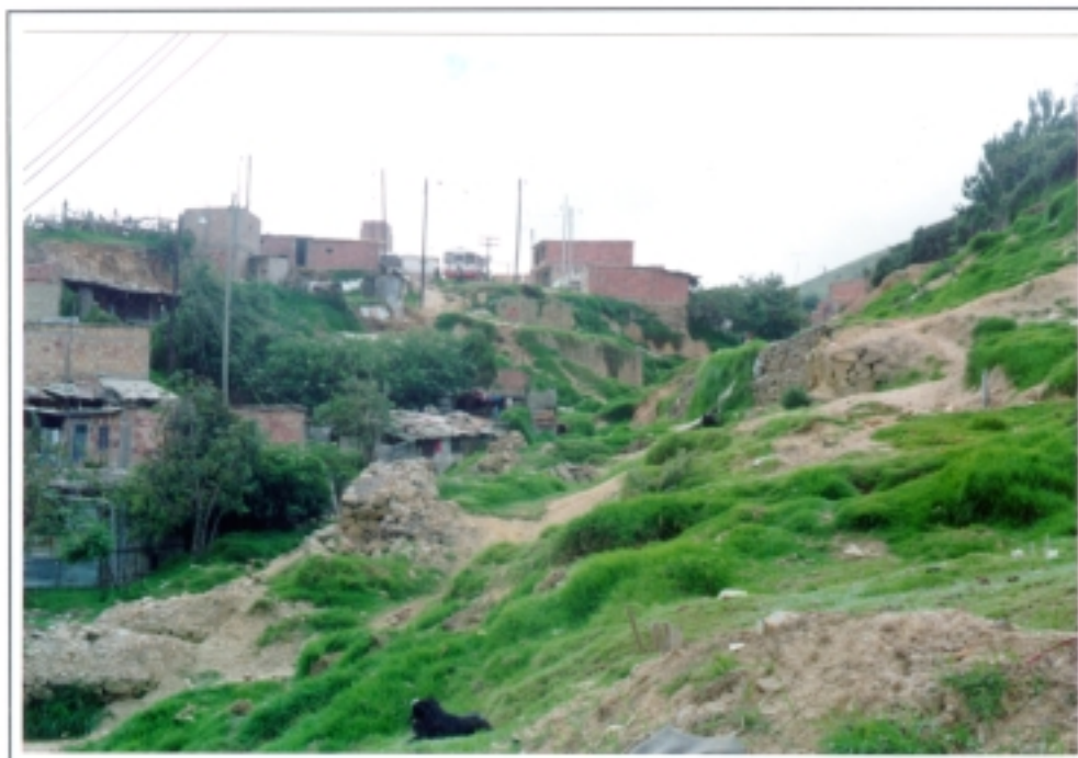
ROLLO 9044 Barrio Nueva Colombia FOTO 18 Construcciones sobre material inestable. Muros de contención Fenómeno de Rentación
