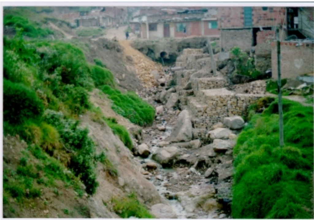
ROLLO 8014 Quebrada el Zuque FOTO 13 Obras de Protección recientes
