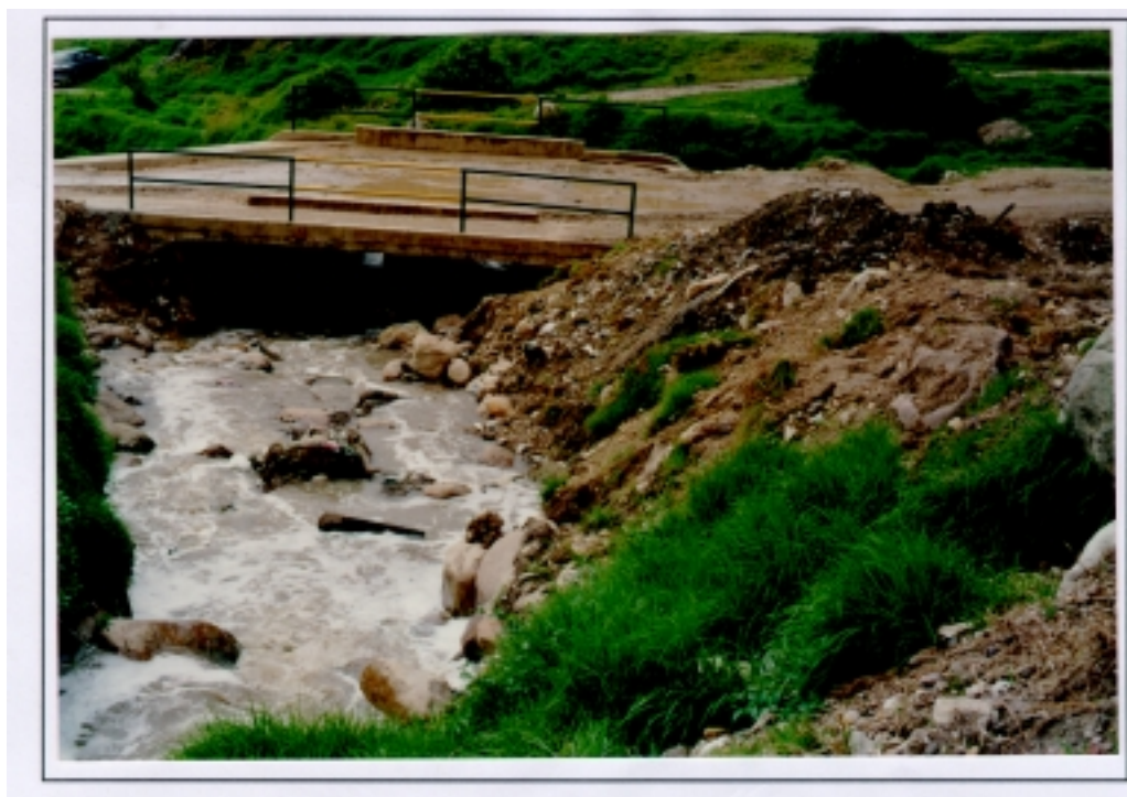
ROLLO 8611 Puente sobre Quebrada afluente a la Quebrada El Zuque FOTO 9
