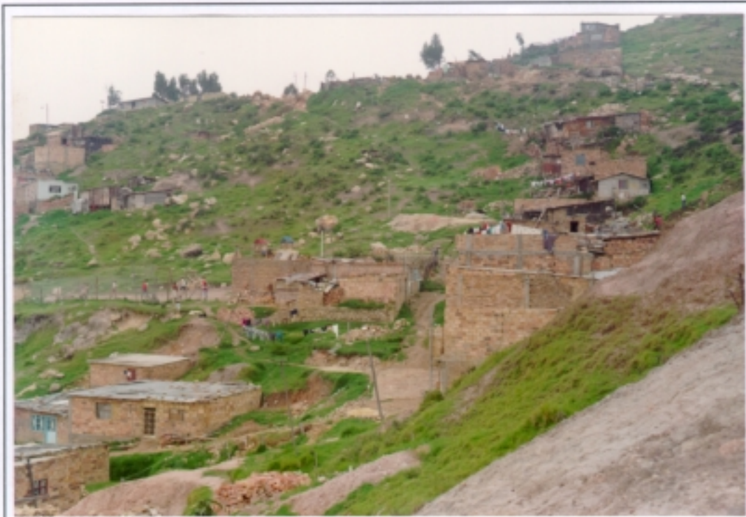
ROLLO 8331 Barrio El Pedregal FOTO 1 Construcciones sobre material inestable
