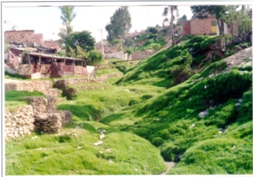
ROLLO 9047 Quebrada Lima – Barrio Nueva Colombia FOTO 37 Edificaciones sobre material inestable y obras de protección debilitadas
