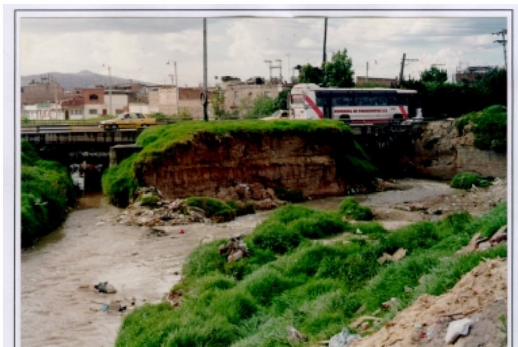
ROLLO 9047 Quebrada El Zuque a la altura de la Avenida Caracas FOTO 15
