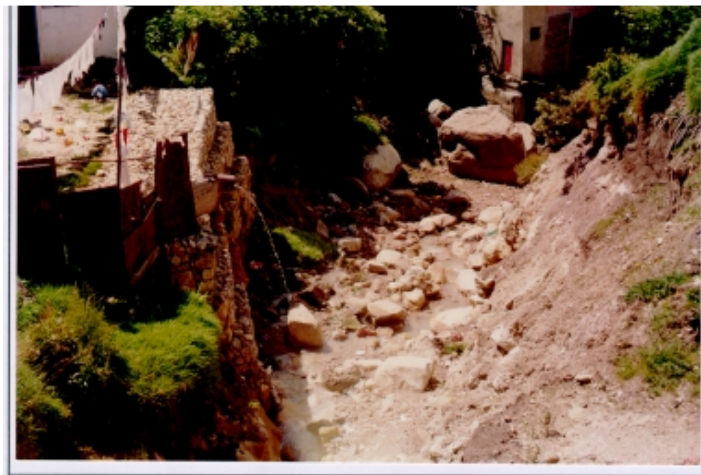
ROLLO 9094 Quebrada el Zuque FOTO 12 Socamiento de La Quebrada
