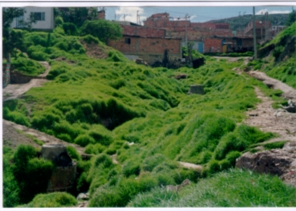
ROLLO 9430 Barrio Jerusalén FOTO 1 Sistema de alcantarillado deficiente
