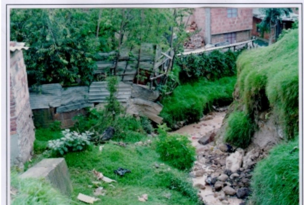
ROLLO 8612 Barrio Nueva Gloria FOTO 12 Casas sobre el lecho de la Quebrada y socavamiento de estas.
