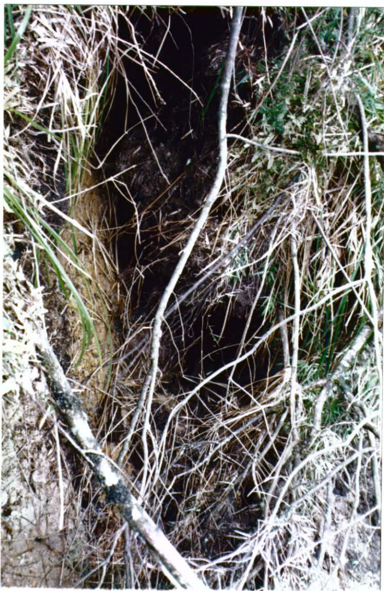
- Agrietamiento y desprendimiento en la parte media de la montaña, con más de 30 centímetros de separación. Lugar por donde la quebrada "desfogó" sus aguas represadas.
