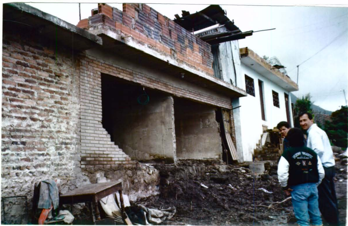
- Funcionarios de la Personería observan los estragos en el barrio Moralba, originados por desprendimientos de tierra removida por urbanizadores.
