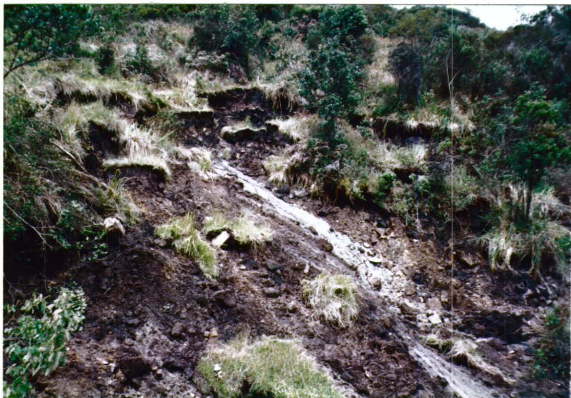
- Nacimiento de la quebrada Zuque o Pichosa, desprendimiento por sedimentación de materiales provenientes de la cantera que taponaron nacimiento habitual.
