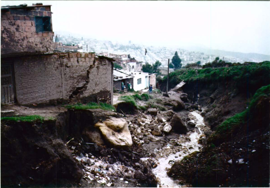
- La avalancha amplió el cause de la quebrada (barrio Quindío)
