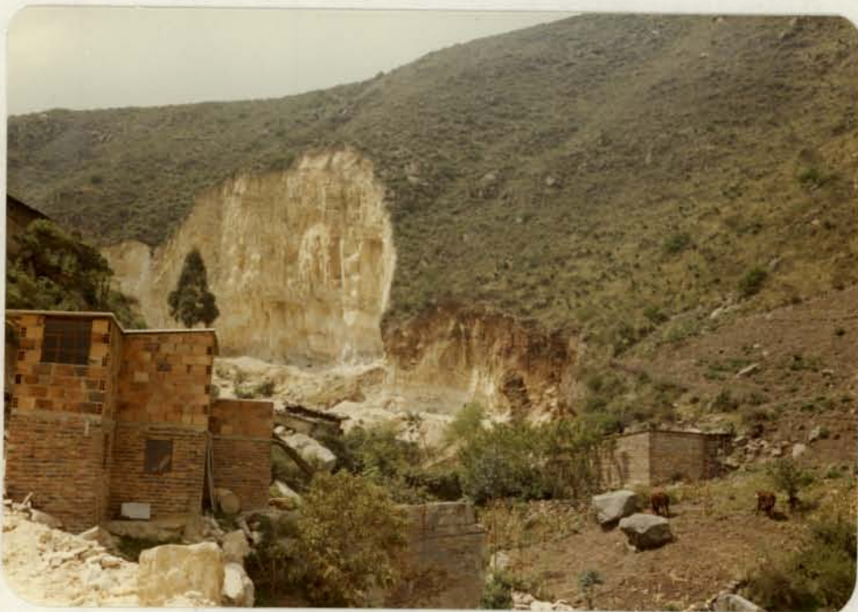
Foto 10.- Explotación de piedra y recebo de la Arenisca Labor. Q. de Limas, sur de Bogotá.
