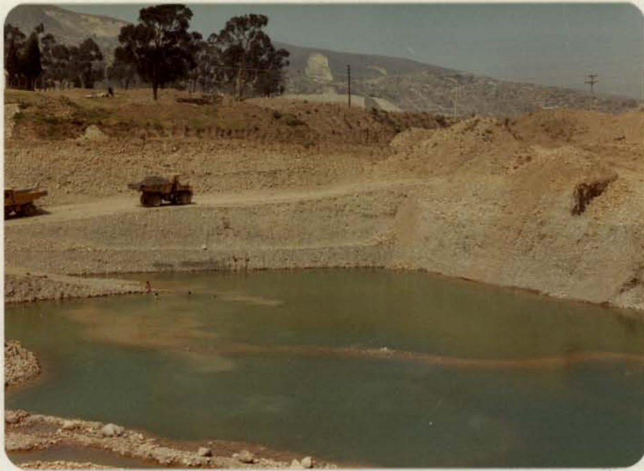
Foto 39.- Zona Tunjuelo. Explotación de aridos y minerales junto a la Escuela, cada volqueta carga 25 toneladas. Nivel freático a 18 m.
