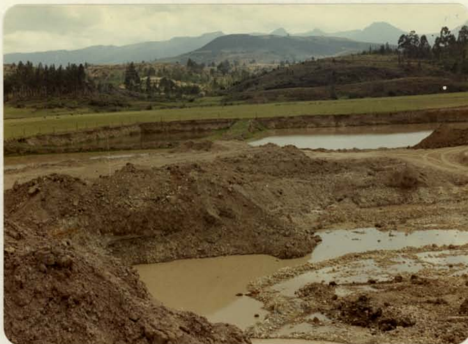
Foto 45.- Huecos dejados por la explotación de la firma "Agregados de la Sabana" en el extremo S del Embalse de Guatavita. El descapote es mas o menos 1.5 m. El nivel freático está mas o menos 7 m. El espesor de las gravas es de 5 a 7 m. La base de las gravas son arcillas plásticas.
