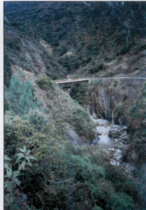
Foto 2-5. Puente sobre el río Santa Rosa.
