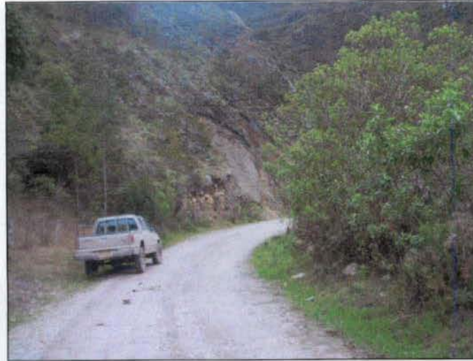
Foto 4-24. Desprendimiento de depósitos de talus en el talud interior de la vía que conduce a Betania antes del cruce del puente sobre el río Santa Rosa.
