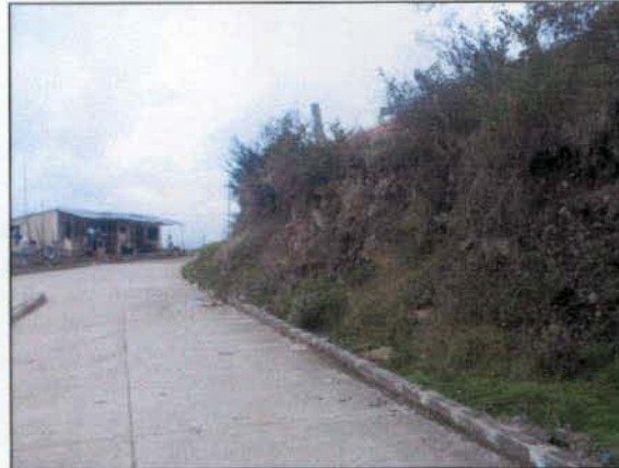
Foto 4-3. El talud oriental de la carretera de acceso muestra la litología típica de coluviones.
