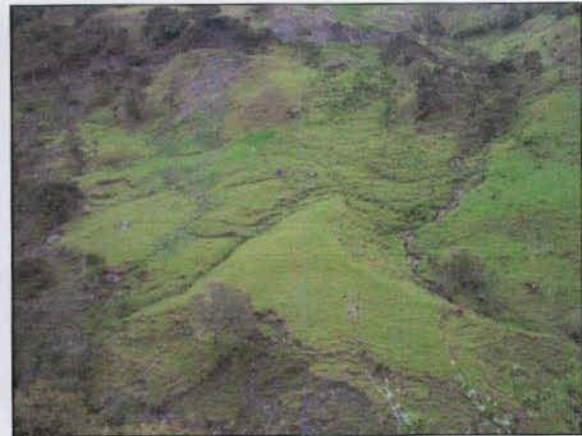
Foto 4-17. Aspecto de los deslizamientos sobre la margen izquierda del río Santa Rosa hacia la parte alta se observan los cortes de la vía a Betania.
