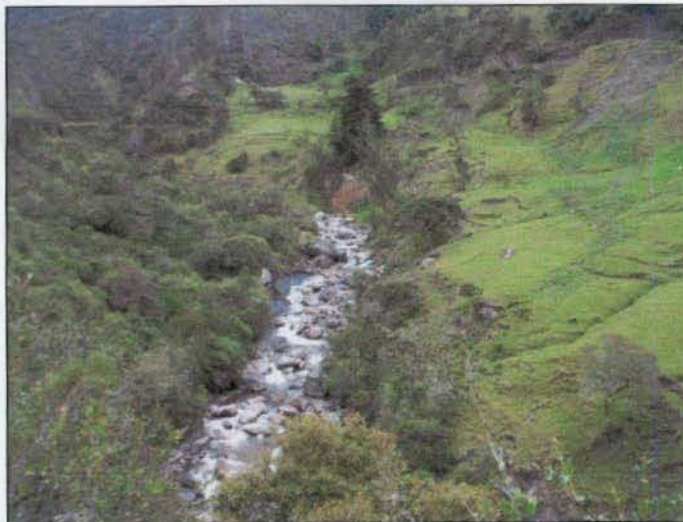
Foto 4-23. Presencia de grandes cuerpos deslizantes sobre la margen izquierda del río Santa Rosa que no tienen efectos para la estabilidad del casco urbano.
