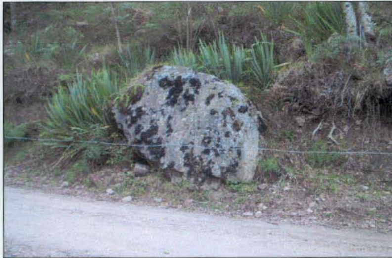
Foto 4-15. Detalle del bloque de un depósito coluvial en el talud interior de la vía de acceso.
