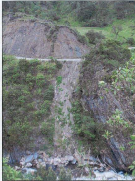
Foto 4-18. Se observa el material dispuesto en el costado exterior de la vía producto de la descarga del talud interior.
