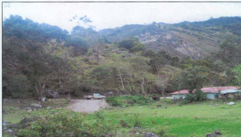
Foto 4-14. Al costado derecho enfrentado con el techo de las casas se presenta el depósito coluvial y hacia la izquierda el bloque que se desprendió del talud interior.
