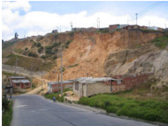
Fotografía 3. Presencia de viviendas de recuperación en la parte alta del talud fallado. Su número ha aumentado en el último año.
