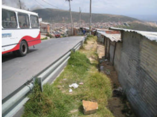
Fotografía 13. La vía que conduce hacia el Barrio Los Alpes se encuentra a 4m del escarpe rocoso del deslizamiento actual.
