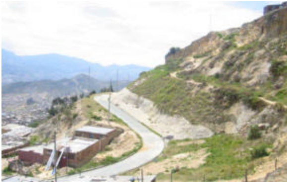
Fotografía 1. Vista del talud en abril de 2005. El sendero peatonal a mitad de talud abarcaba pocos metros de ancho.
