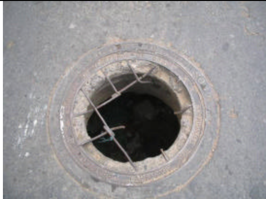
Fotografía 7. Los pozos de alcantarillado a lo largo de la vía se encuentran obstruidos por basuras.
