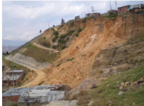
Fotografía 2. Vista del talud en julio de 2006. El sendero peatonal fue ampliado para la construcción de obras en el talud sur.
