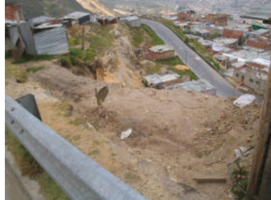
Fotografía 14. En la parte alta del escarpe se observan grietas de bloques que amenazan con desprenderse.
