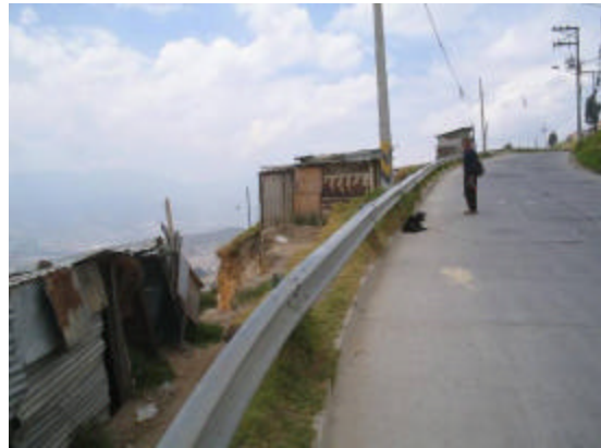
Fotografía 4. Las viviendas de recuperación cercanas al escarpe rocoso están construidas en latas y madera.
