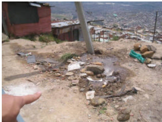
Fotografía 9. Las redes clandestinas de suministro de agua presentan en algunos casos fugas que contribuyen al aporte de agua del talud.
