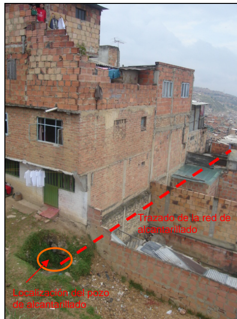
Fotografía 6-2 Parte posterior de la Vivienda Calle 65 D Bis S No. 18N-84
