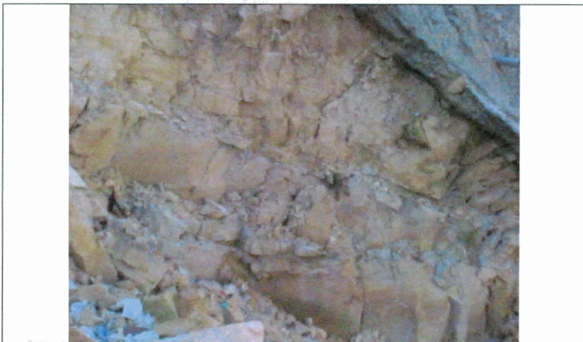
Fotografía 3-1 Intenso fracturamiento y brechamiento que trae como consecuencia alta permeabilidad secundaria e infiltración de aguas desde la parte alta.
